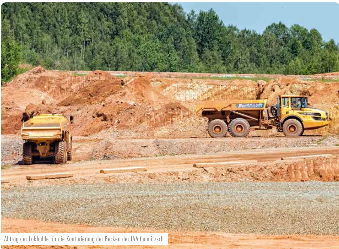
Einbringen von Tiefdrains im Becken A der IAA Culmützsch
