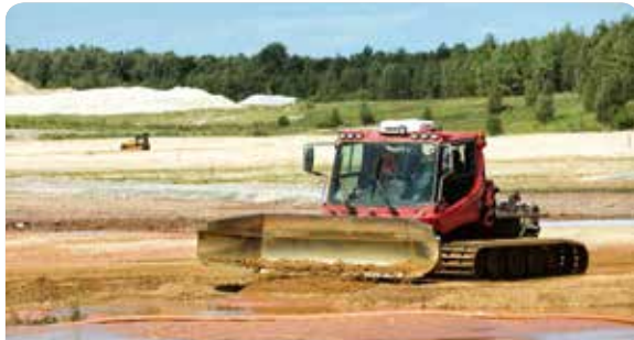
Letzte Zwischenabdeckung auf der IAA Culmitzsch
