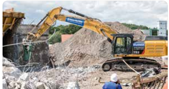
Rückbau des Pipe Conveyors am Standort Crossen
