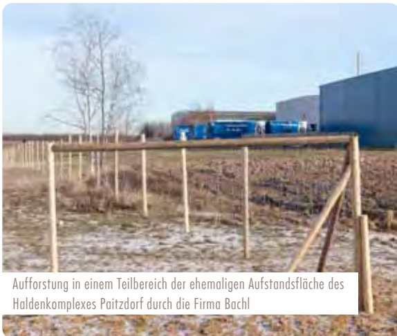
Bauarbeiten zur Errichtung eines begehbaren Grubengelechts als Landmarke auf dem Aufschüttkörper Tagebau Lichtenberg
