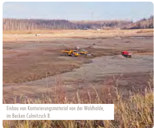
Abtrag und Neukonturierung im Bereich Waldhalde
