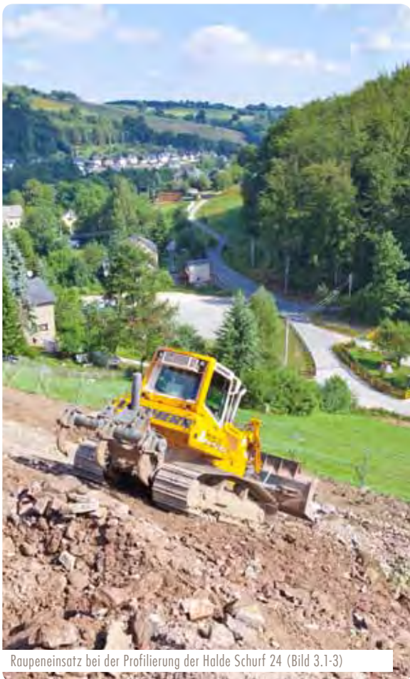
Halde Schurf 24 während der Restprofilierung an der NO-Böschung (Bild 3.1-1)
