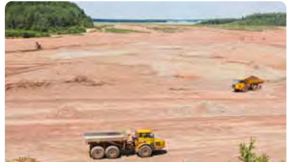
Einbau von Haldenmaterial zur Konturierung des Beckens B (Bild 8.1-3)
