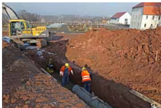
Wiedernutzbarmachung Fläche Schutzdamm Ronneburg, Verlegen der Entwässerungsleitung (Bild 6.1-15)
