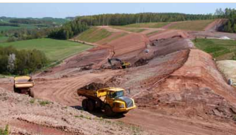
Konturierungsarbeiten am Norddamm der IAA Culmitzsch, Blick auf die fertiggestellte Kontur der Jashalde und von Teilbereichen des Norddammes, Mai 2008 (Bild 8.1-7)
