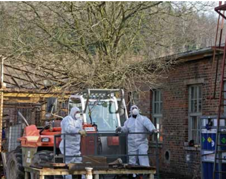
Mitarbeiter bereiten sich auf Abbrucharbeiten vor, Februar 2008 (Bild 9.1-2)
