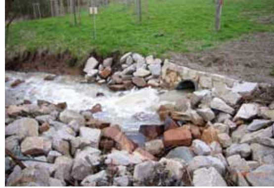
Auslauf Bypassleitung (Bild 6.1-6)
