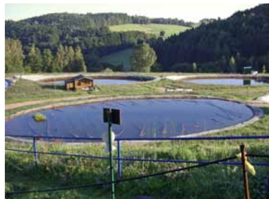
Teilansicht der Anlage zur passiv-biologischen Behandlung von Grubenwasser der Grube Pöhla (Bild 3.1-3)
