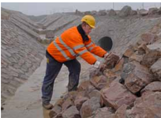
Schwerer Wasserbau auf dem Aufschüttkörper Lichtenberg (Bild 6.1-12)
