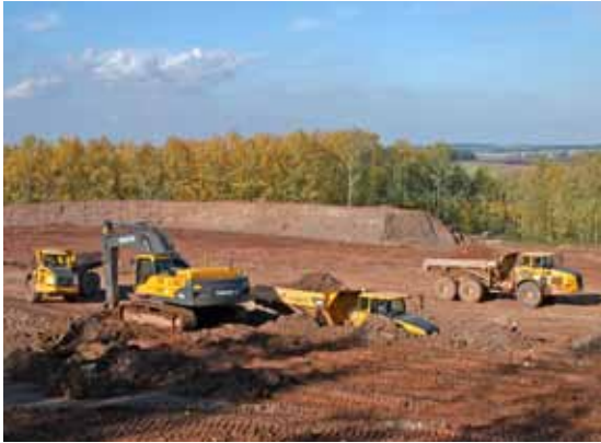
Abtrag von Waldhaldenmaterial für den Konturauftrag im Becken B der IAA Culmitzsch mit Blick auf den Schutzwall in Richtung Wolfersdorf, Oktober 2008 (Bild 8.1-9)
