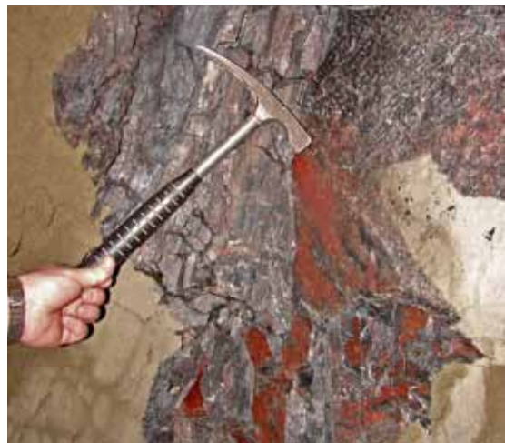
Detailaufnahme der Gebirgssituation (Tektonische „Harnische“ als Gleitflächen) beim Vortrieb der Auffahrung nach SE (Bild 5.1-4)
