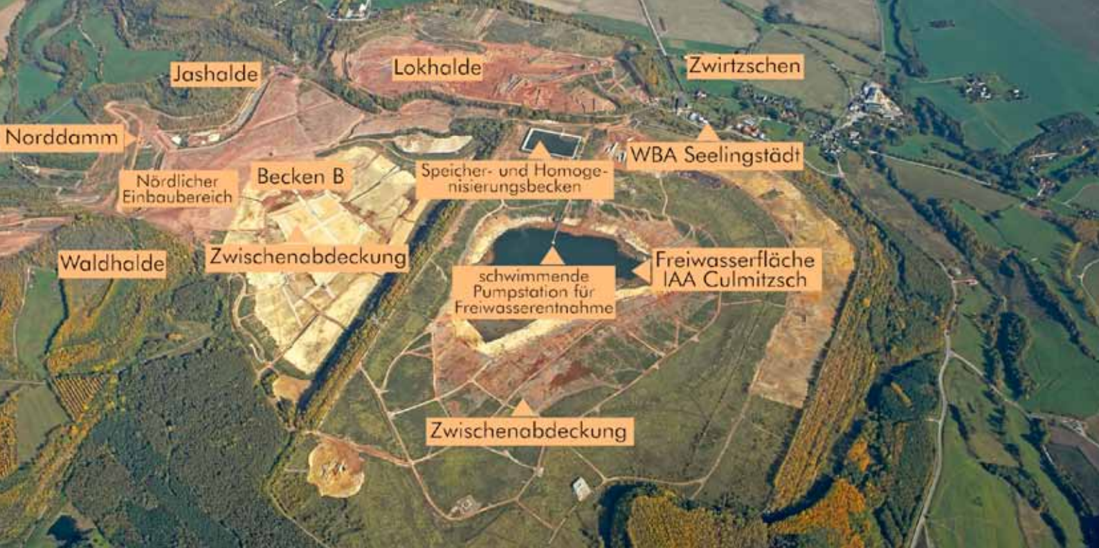
Gesamtansicht IAA Culmitzsch, Oktober 2008 (Bild 8.1-6)
