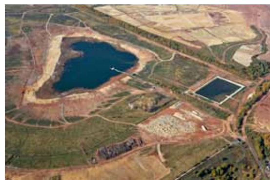
Speicher- und Homogenisierungsbeckens, IAA Culmitzsch Becken A Freiwasserfläche sowie Bauschutzzwischenlager, Oktober 2008 (Bild 8.1-5)
