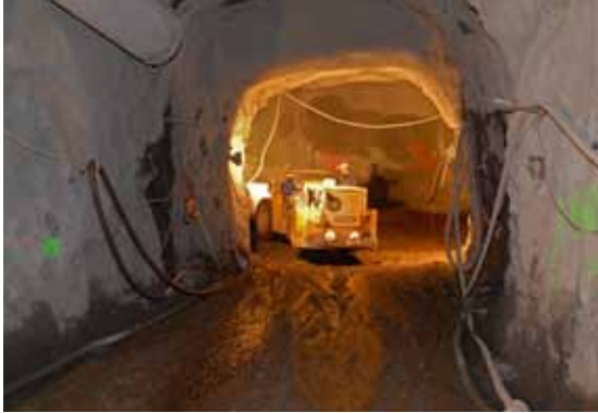
Tiefster Punkt der Rampe als Zugang zum WISMUT-Stolln, Streckenkreuz (Bild 5.1-2)
