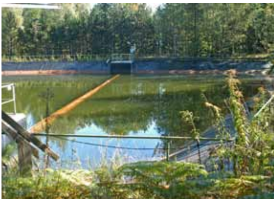
Ehemaliges Haldenfußbecken unterhalb der Halde Schüsselgrund (Bild 4.1-5)
