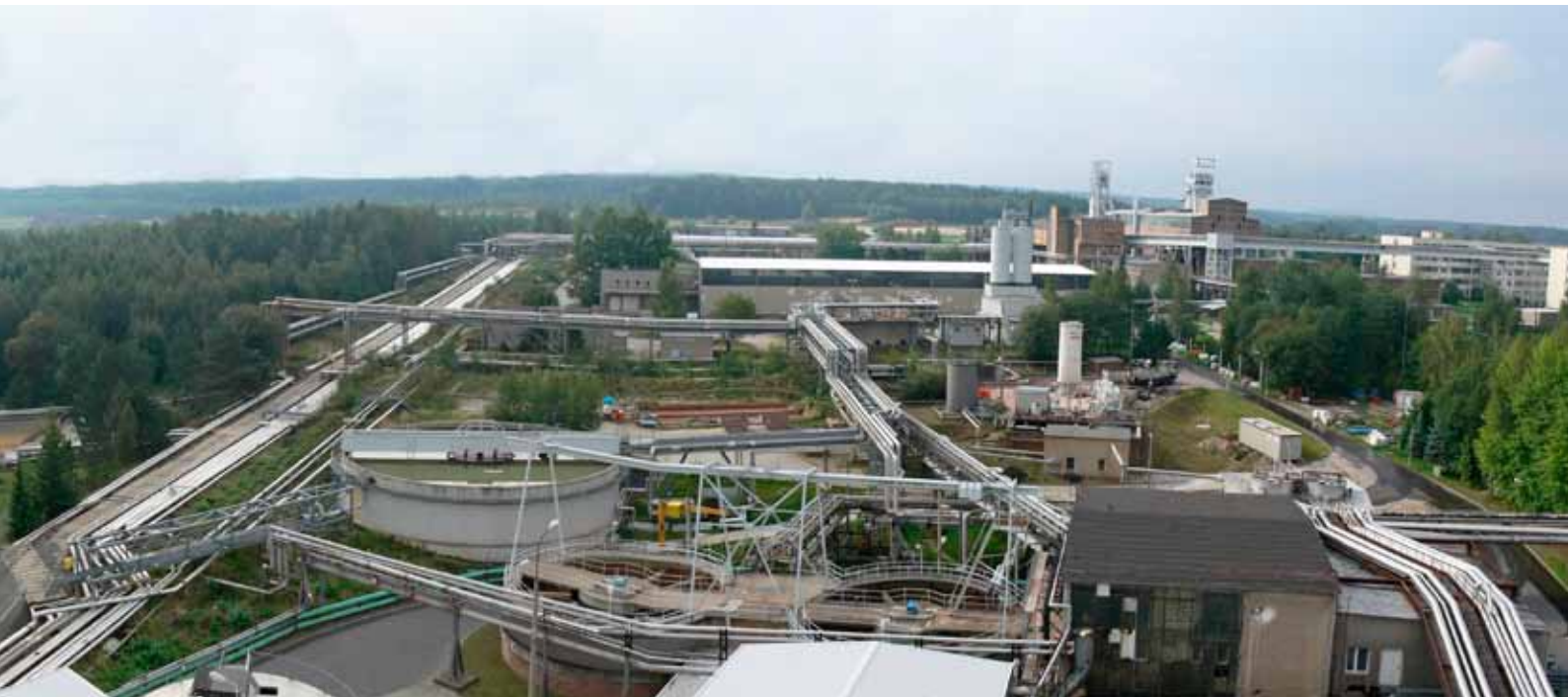
Blick auf einen Teil des Betriebsgeländes Königstein, rechts im Hintergrund die Fördergerüste Schacht 390 und 388 (Bild 4.1-1)
