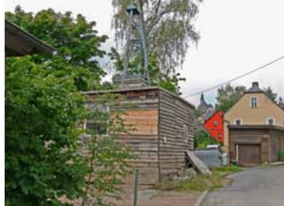
Untersuchungsgesenk 237 in der Ortslage Oberschlema (Bild 2.1-2)
