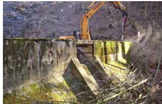
Abbrucharbeiten am Kleinstabecken (Bild 2.1-7)
