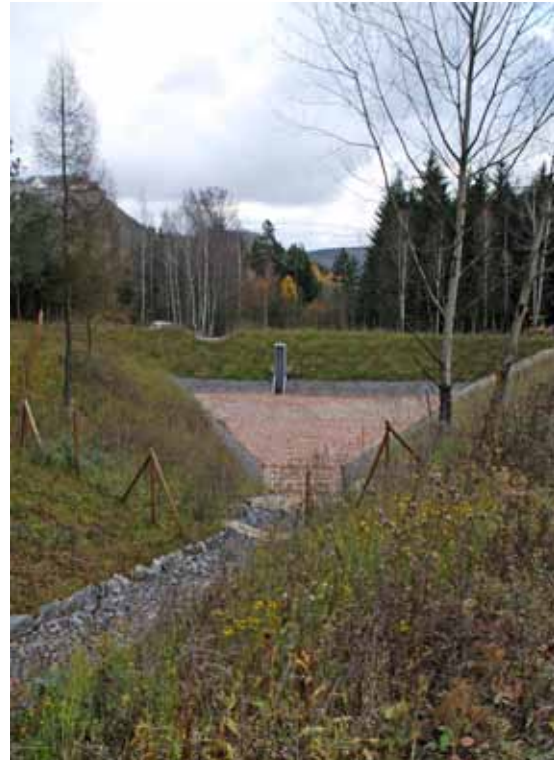
Regenrückhaltebecken, November 2008 (Bild 4.1-6)
