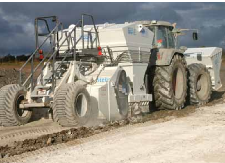
Technik zum Aufbringen und Einarbeiten von reaktivem Material im Einsatz auf der Plateaufläche Halde Schüsselgrund, November 2008 (Bild 4.1-9)
