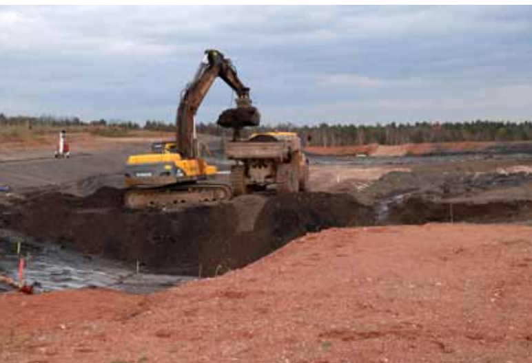
Abtrag und Verladen von Tailings aus dem künftigen Gerinneinschnitt IAA Dänkriz I, Oktober 2008 (Bild 7.1-2)
