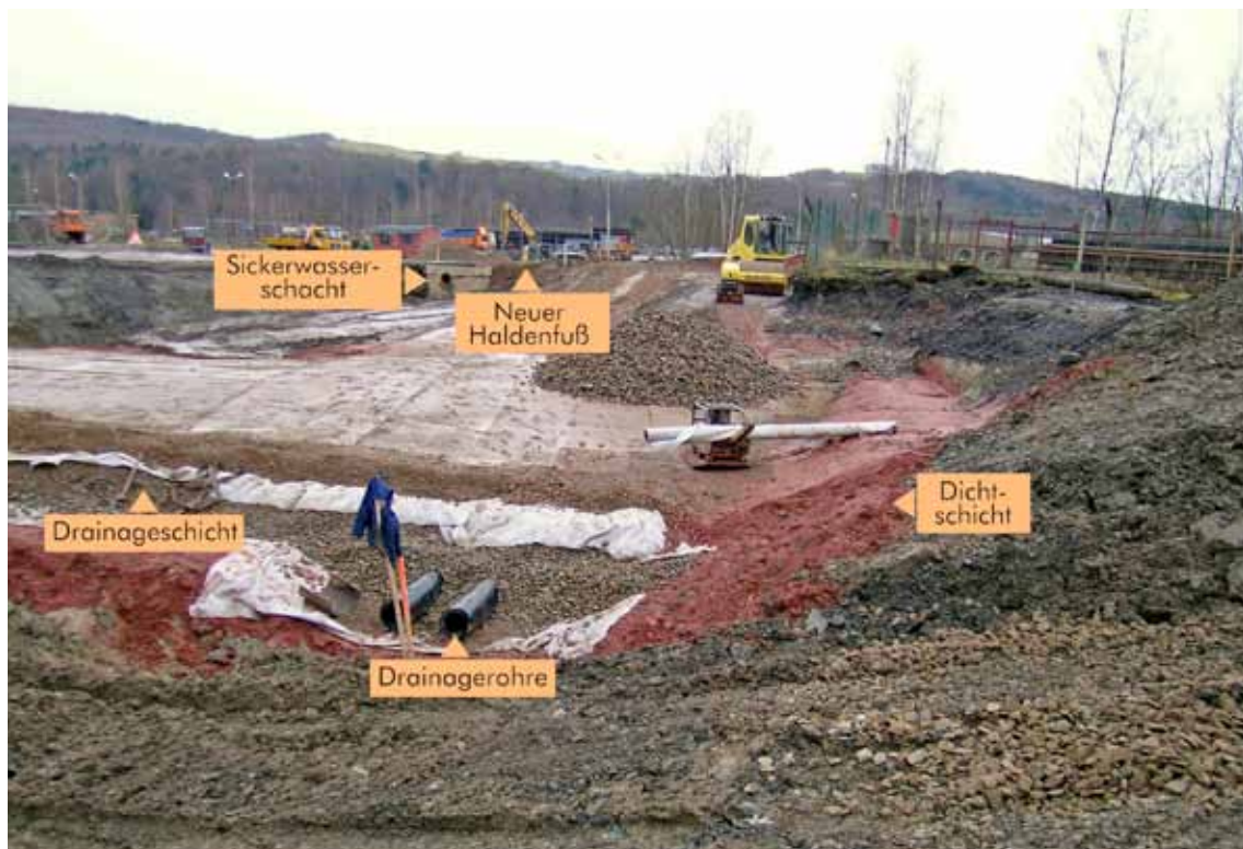
Umbau des ehemaligen Feuerlöschteichareals zur Sickerwasserableitung an der Halde 371/I, Dezember 2007 (Bild 2.1-4)
