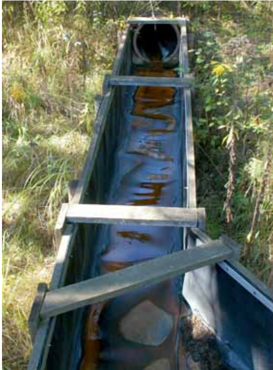
Zuleitung zum ehemaligen Haldenfußbecken, September 2007 (Bild 4.1-7)
