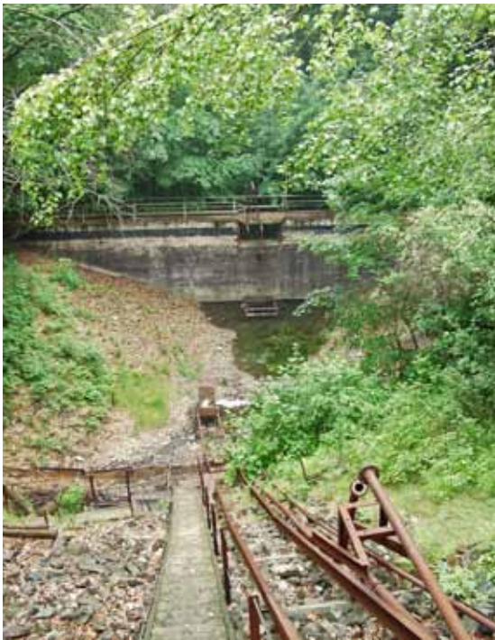
Blick von der Halde 371/II auf das Kleinstabecken vor der Sanierung (Bild 2.1-6)
