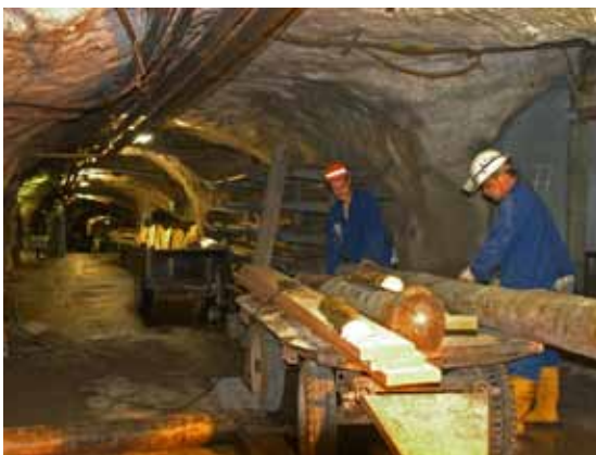
Sanierungsarbeiten im Zusammenhang mit dem Rückbau der technischen Ausrüstung im Grubenfeld Süd auf der 135-m-Sohle (Bild 4.1-4)
