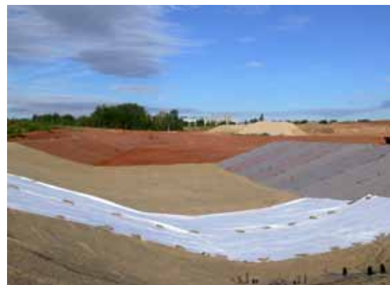
Bau des Homogenisierungsbeckens, August 2008 (Bild 7.1-3)
