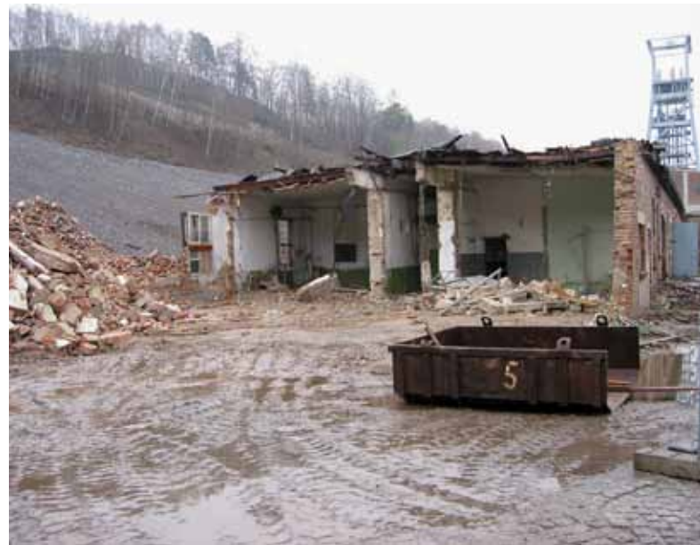
Abbruch des Werkstattkomplexes am Schacht 371 (Bild 9.1-3)
