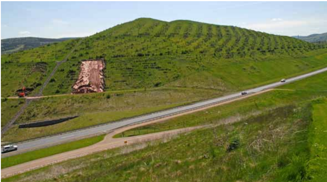
Reparatur der Rutschungen an der Halde 366, Mai 2008 (Bild 2.1-9)
