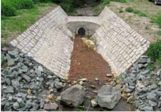
Einlauf Bypassleitung (Bild 6.1-5)
