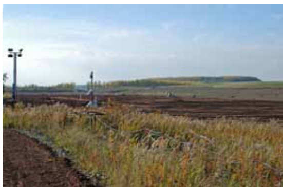
Realisierung der Endabdeckung im Becken A der IAA Trünzig, Oktober 2008 (Bild 8.1-3)
