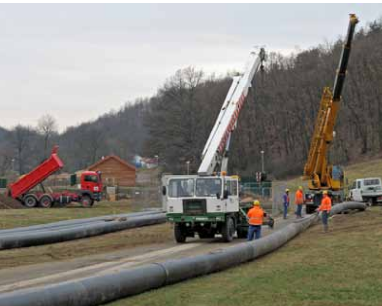
Verlegung der Bypassleitung im Gessental (Bild 6.1-4)
