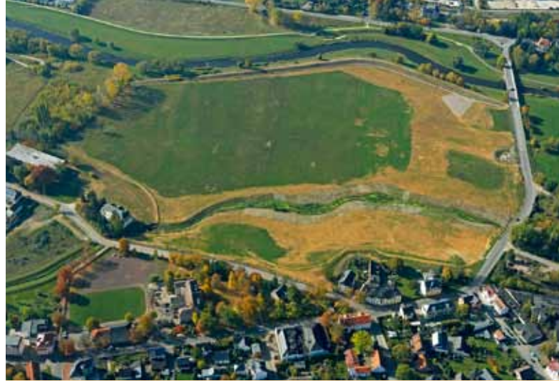
Sanierte Betriebsfläche des ehemaligen Aufbereitungsbetriebes Crossen, Oktober 2008 (Bild 7.1-5)
