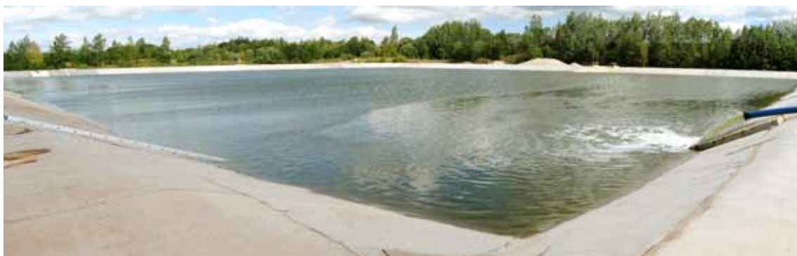
Neu errichtetes Speicher- und Homogenisierungsbecken am östlichen Rand des Beckens A der Absetzanlage Culmitzsch, August 2008 (Bild 8.1-4)
