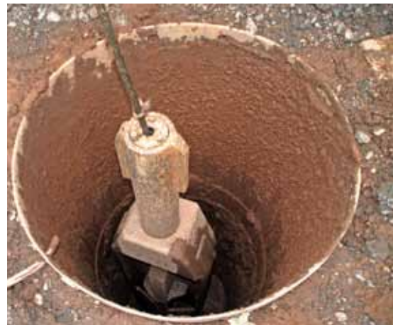
Errichtung des Wetterbohrloches WISMUT-Stolln Freital, Bohrllochdurchmesser 1200 mm, Greifer fördert Bohrgut an die Tagesoberfläche, Juli 2008 (Bild 5.1-7)
