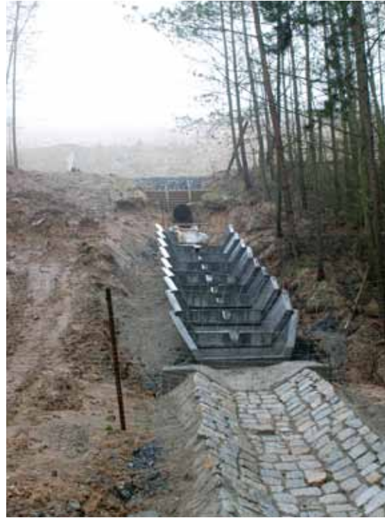
Neu gebaute Kaskade oberhalb des Regenrückhaltebeckens, Januar 2008 (Bild 4.1-8)
