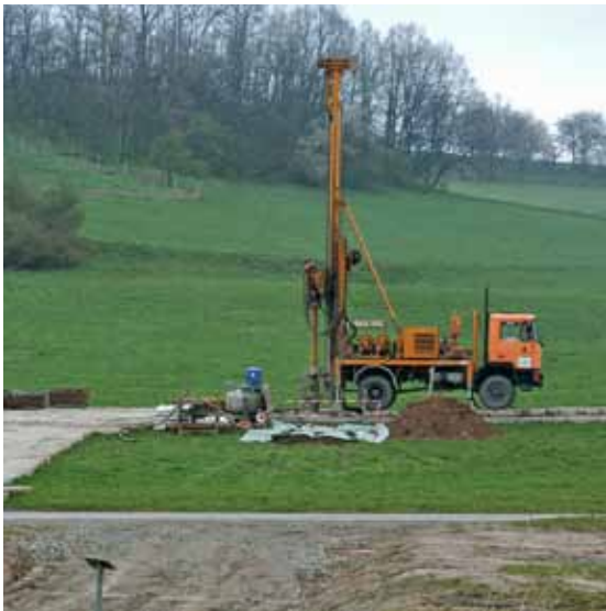
Verwahrung von Altbohrungen im Gessental (Bild 6.1-7)
