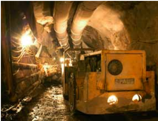
Radlader beim Transport des Haufwerkes im Bereich der Rampe, Februar 2008 (Bild 5.1-5)
