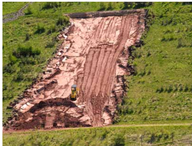
Detailaufnahme von den Reparaturarbeiten Halde 366, Mai 2008 (Bild 2.1-11)
