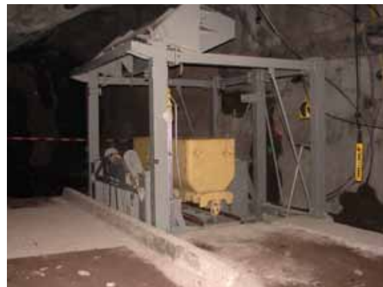
Huntekippanlage im WISMUT-Stolln, Juli 2008 (Bild 5.3-1)
