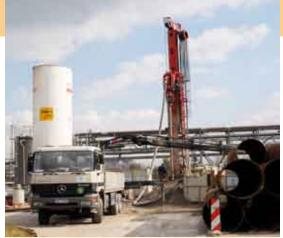
Bild 4.1-1 Standort Königstein, Bohrmaschine zur Herstellung Förderbohrloch
