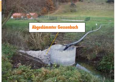
Bild 6.1-4 Abgedämmter Gessenbach, im Hintergrund die Pumpenstation des Wasserfassungssystems, November 2006
