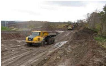
Bild 6.1-10 Abtrag des ehemaligen Schutzdammes Ronneburg, im Hintergrund der Entdeckerturm auf dem BUGA-Gelände
