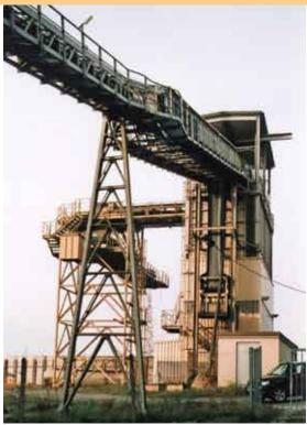
Bild 7.1-1 Pipe Conveyor und Silostation auf der IAA Helmsdorf, Abtrag Halde Crossen
