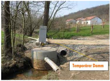
Bild 6.1-5 Gessenbach wird angestaut, im Hintergrund die kommunale Kläranlage Ronneburg, Dezember 2006
