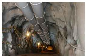
Bild 5.1-4 Auffahrung der Rampe zum WISMUT-Stolln
