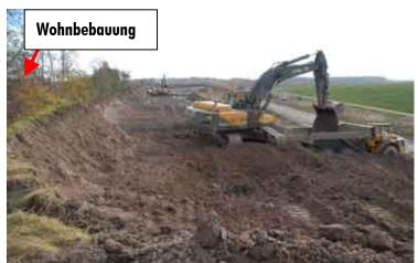
Bild 6.1-9 Abtrag des ehemaligen Schutzdammes Ronneburg in unmittelbarer Nähe der Wohnbebauung, November 2007
