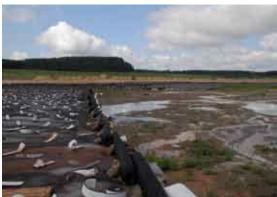
Bild 8.1-8 Fläche mit eingebrachten Vertikaldräns auf der IAA Culmitzsch, Becken A, Juni 2007
