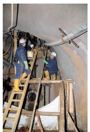
Bild 4.1-2 Standort Königstein, Rückbau techn. Ausrüstung und Versatzdammbau
