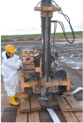
Bild 8.1-9 Mitarbeiter des Projektes Bohrung beim Einbringen von Vertikaldräns, Juni 2007
