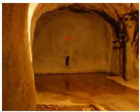
Bild 4.1-4 Standort Königstein, Absperrdamm in einer Strecke
