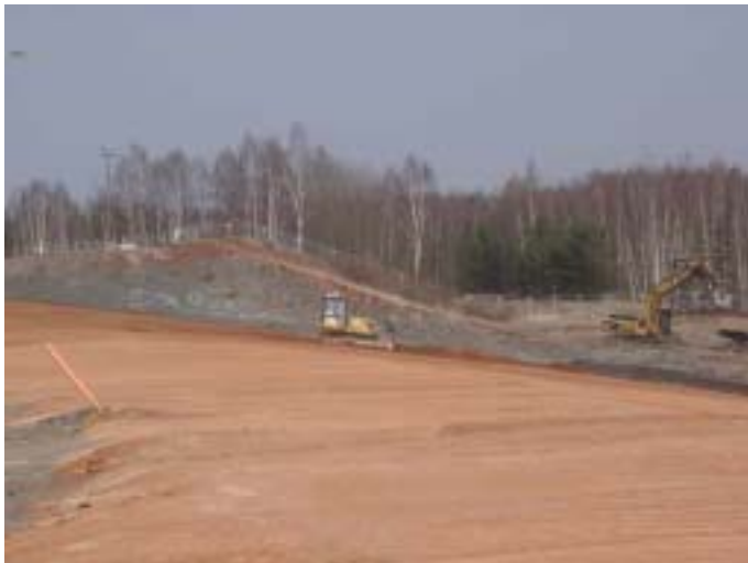
Bild 2.5-1 IAA Dänkritz I – Konturierung des Ringdamms, Abdeckung mit Rotliegendem (Stand: Ende März 2003)
