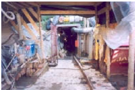
Bild 2.4-3 Pietzsch-Stolln-Mundloch mit Baustelleneinrichtung und Verlauf der Einschienenbahn
