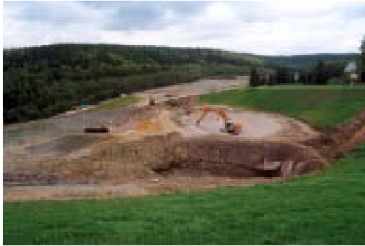
Bild 2.2-1 Bau des Constructed Wetland in Pöbla – August 2003
