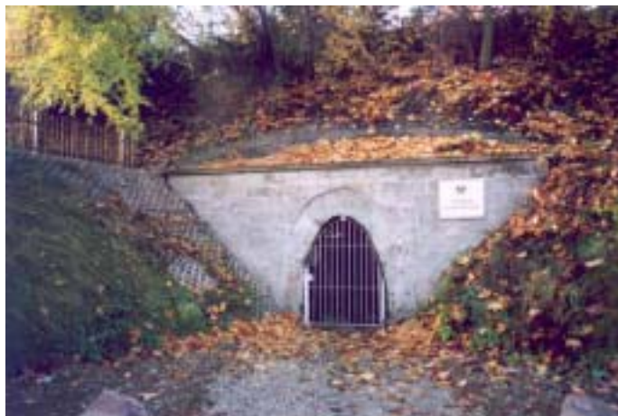
Bild 3-5 Niederlassung Königstein, Standort Dresden-Gittersee, Fläche am Elbstollnmundloch nach Abschluß der Sanierungsarbeiten – Stand Oktober 2003
