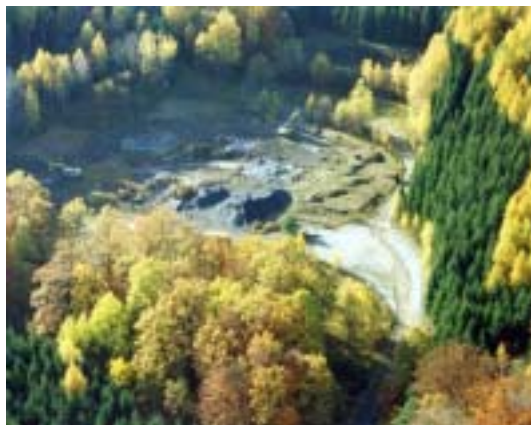
Bild 2.3-2 Fläche Schacht 387 während der Sanierungsarbeiten, September 2003
