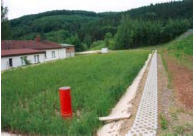
Bild 2.1-2 Constructed Wetland Schacht 371 (Mai 2003)
