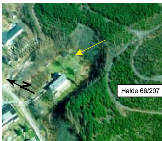
Bild 4.2.2-2 Halde 66/207, Bereich Edelhofweg, vor der Sanierung (gelb markiert: Ort der Radonkonzentrationsmessung MP 511.44)
