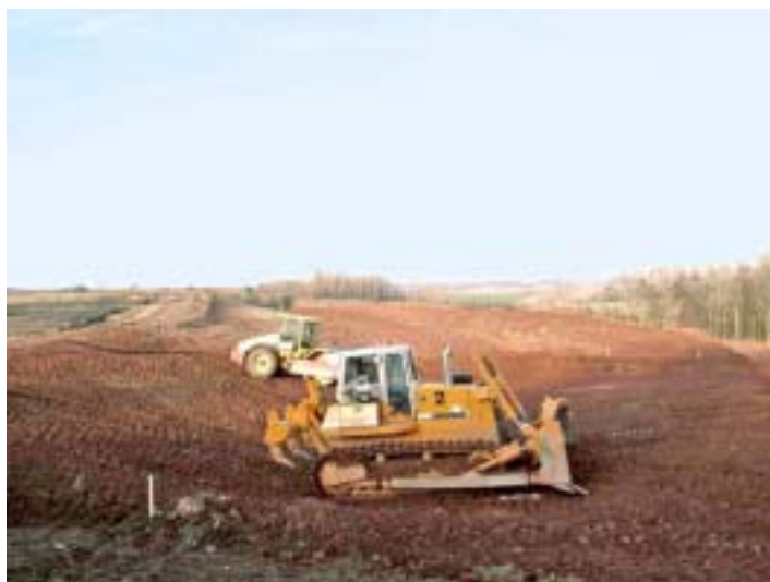
Bild 2.7-1 IAA Trünzig – Konturierung des Karbonathauptdamms
