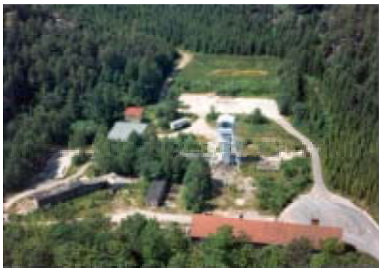
Bild 2.3-1 Fläche Schacht 387 mit Förderturm vor Beginn der Sanierung
