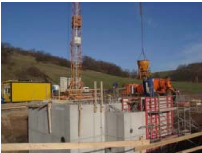
Bild 2.6-2 Sickerwasserfassungssystem Gessental – Pumpstation im Rohbau November 2003
