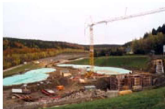
Bild 2.2-2 Bau des Constructed Wetland in Pöbla – Oktober 2003
