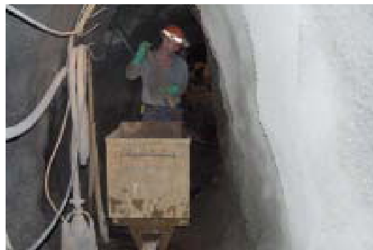
Bild 2.4-4 Aufwältigungsarbeiten im Pietzsch-Stolln
