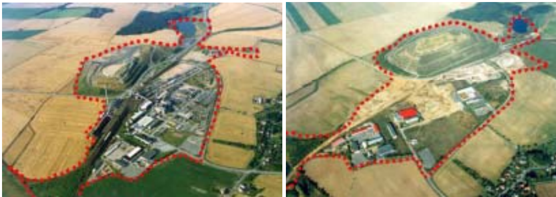
Bild 3-1 Standort Ronneburg, Betriebsfläche Beerwalde vor der Sanierung – Stand Juli 1991
