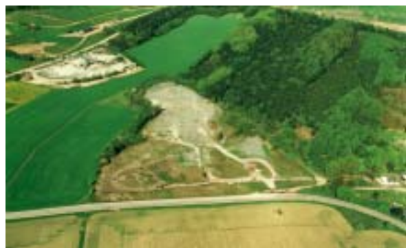
Bild 3-5 ... nach der Sanierung (Stand 2001)
