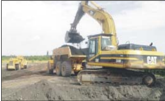
Bild 2.5-3 Abtrag Nord-/Nordwestdamm Konturierung IAA Helmsdorf/Dänkriz I
