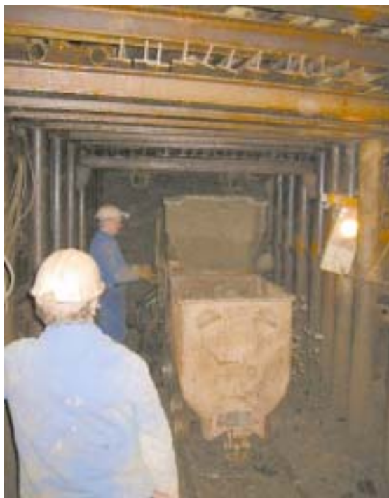
Bild 2.1-1 Aufwältigungsarbeiten mit Wurfschaufel-lader
