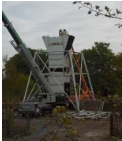
Bild 2.3-2 Demontagearbeiten am Abwetterschacht 387; Oktober 2002
