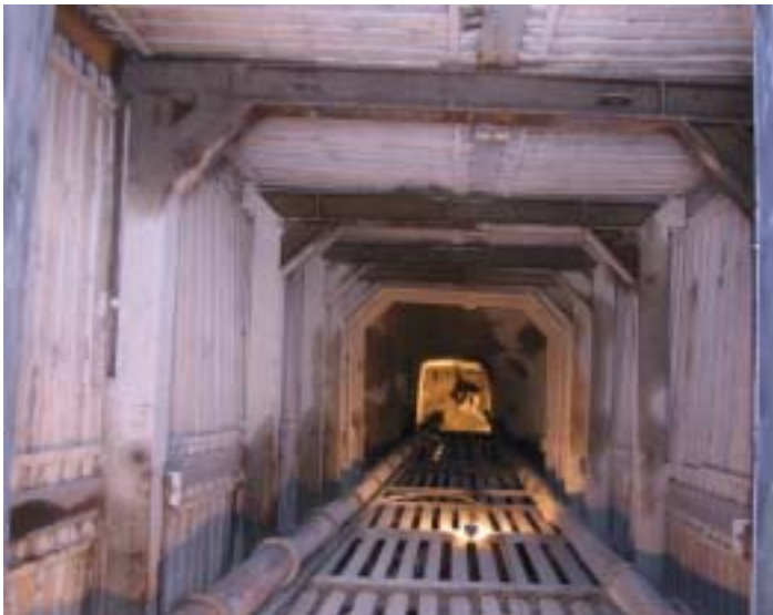
Bild 2.4-2 Blick in die Schachtröhre des Schurfschachtes 60
