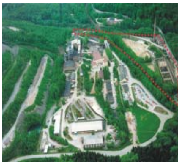
Bild 3-1 Niederlassung Aue (NLA), Standort Schlema-Alberoda Betriebsfläche 371 west (Stand 1994) – vor der Sanierung...
