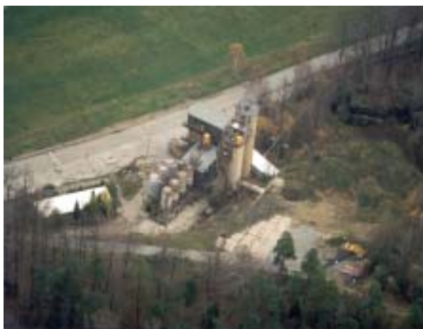
Bild 3-6 Niederlassung Königstein (NLK), Standort Königstein Versatzwerk vor Abbruch, November 1996
