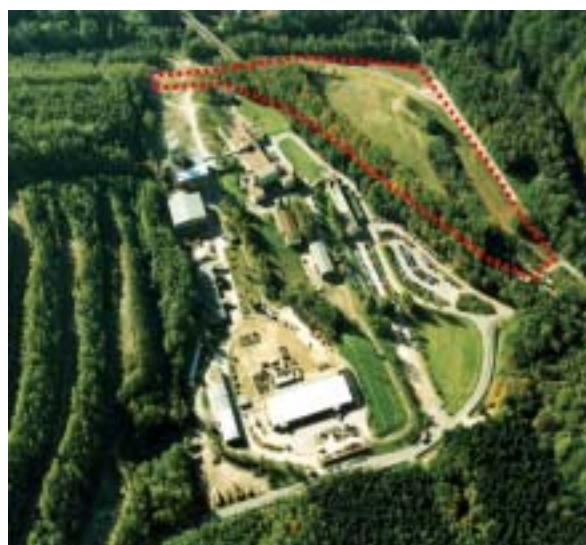
Bild 3-2 ... nach der Sanierung (Stand 2001)
