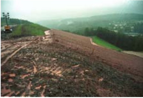
Bild 2.1-5 Halde mit Abdeckung hielten den Niederschlägen am 12./13. August 2002 stand; Halde 38neu/208
