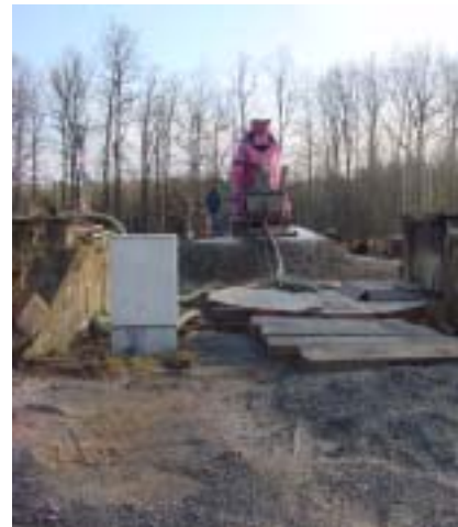
Bild 2.3-3 Verfüllarbeiten am Abwetterschacht 387; Ende November 2002
