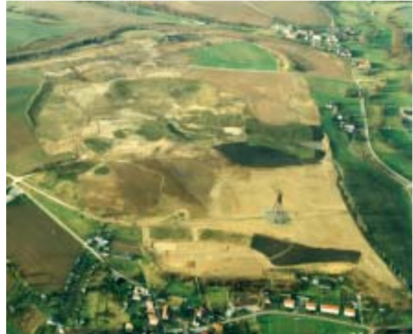
Bild 3-13 sanierte ehem. Betriebsfläche Standort Drosen, Fördergerüst Schacht 403 im Vordergrund – Stand 2002
