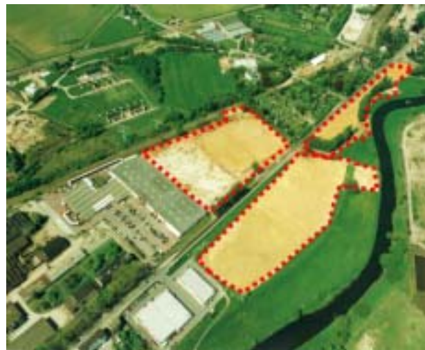
Bild 3-11 ...nach Sanierung – Stand 2002
