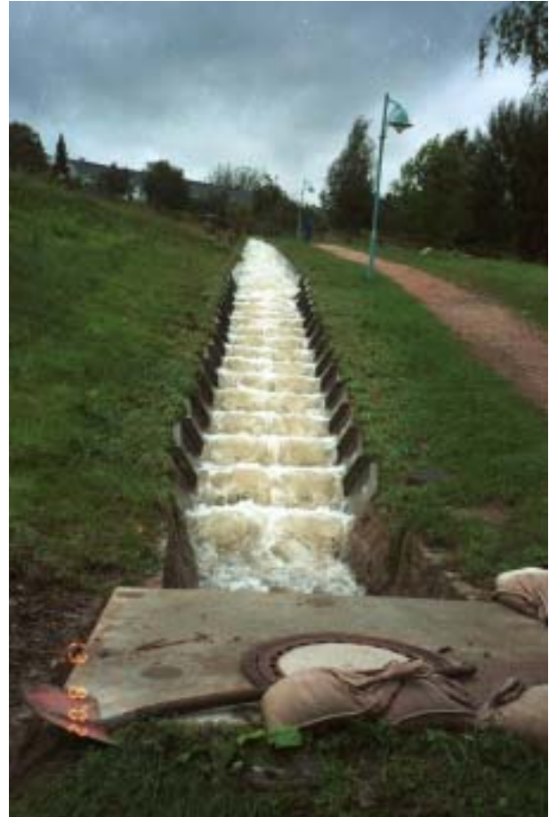
Bild 2.1-5 Halde mit Abdeckung hielten den Niederschlägen am 12./13. August 2002 stand; Halde 38neu/208
