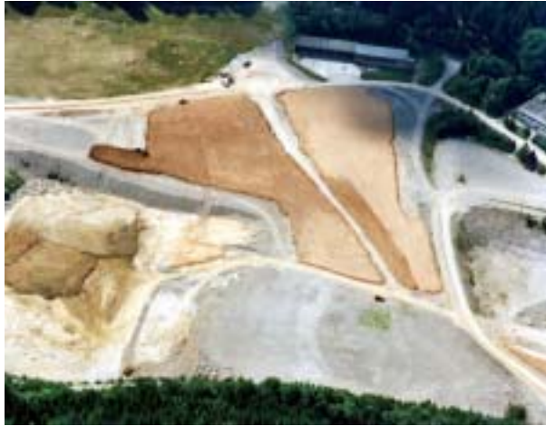
Bild 2.2-1 Abdekarbeiten mittlerer Teil Luchsbachhalde
