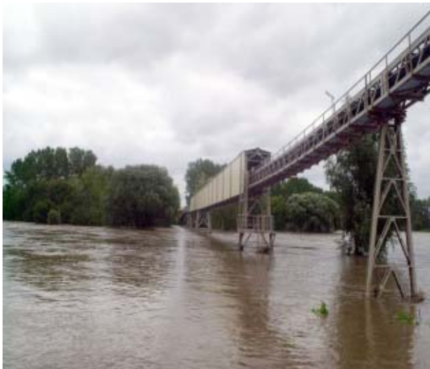
Bild 2.5-5 Der Pipe-Conveyor am Nachmittag des 13. August 2002
