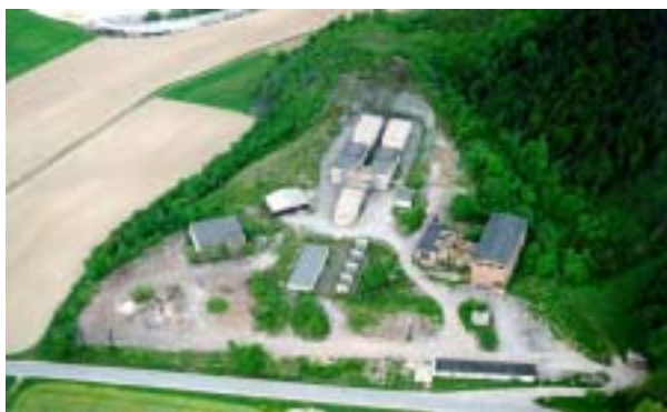
Bild 3-4 NLA, Standort Schlema-Alberoda Betriebsfläche Schacht 373 (Stand 1994)
