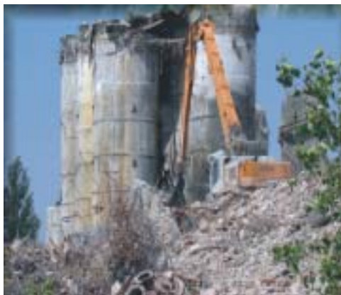
Bild 2.7-2 Abriß der Stahlbetonbehälter der Chemischen Zeche
