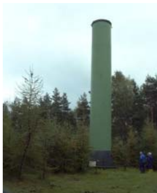
Bild 4.2.2-1 Wetterbohrloch am Standort Königstein
