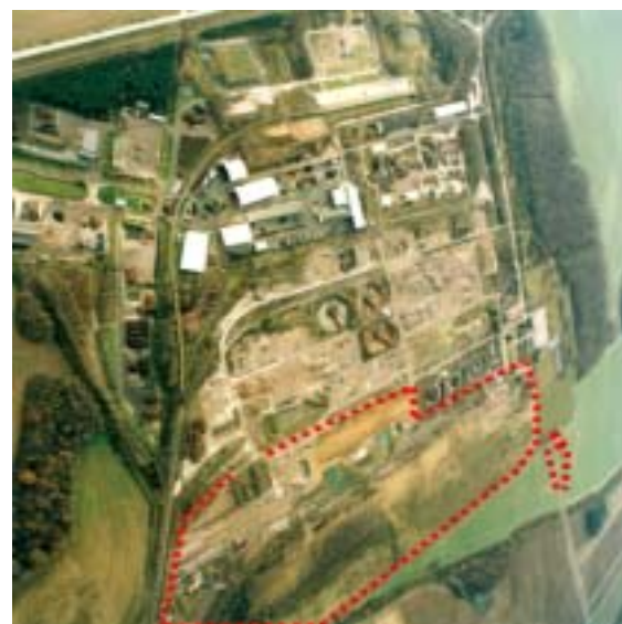
Bild 3-15 Teilsanierte Fläche (Nordbereich) des ehemaligen Aufbereitungsbetriebes Seelingstädt – Stand 2002
