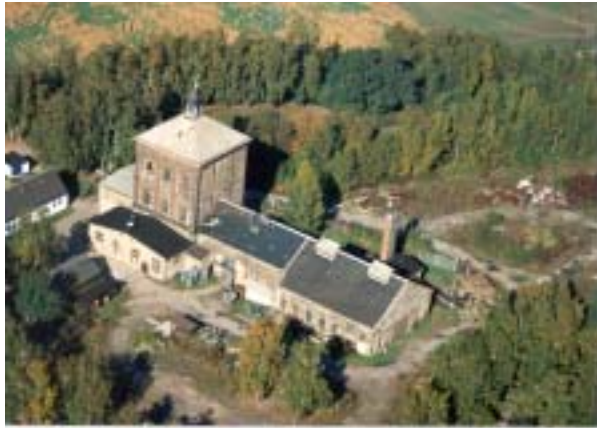
Bild 3-8 NLK; Standort Gittersee, Betriebsgelände Marienschacht vor der Sanierung – Stand 1995
