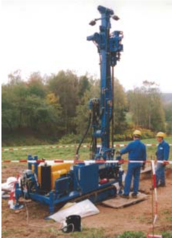
Bild 2.6-2 Arbeiten zur Verwahrung hydraulisch relevanter Altbohrungen im Gessental
