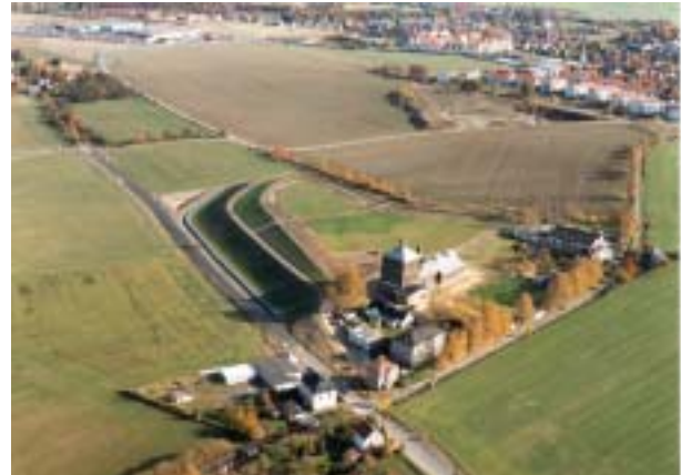
Bild 3-9 Halde und Betriebsgelände Marienschacht nach der Sanierung – Stand 2002
