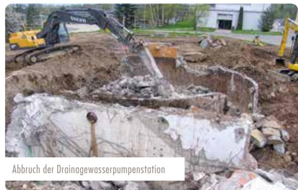
Abbruch der Drainagewasserpumpenstation
