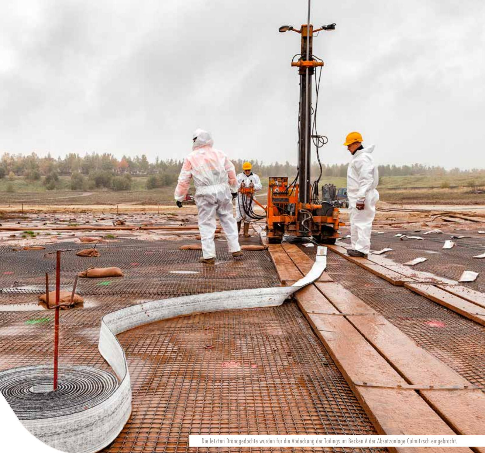
Die letzten Dränagedeute wurden für die Abdeckung der Tailings im Becken A der Absetzanlage Culmitzsch eingebracht.
