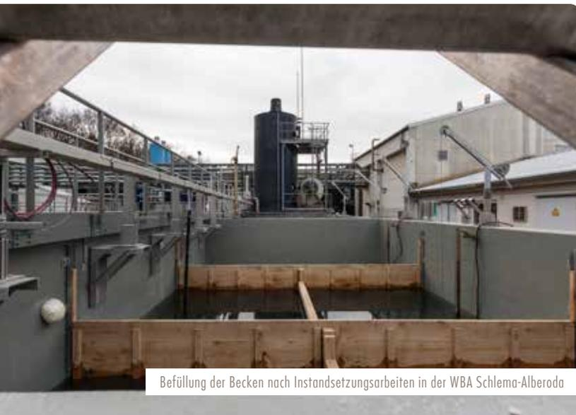
Befüllung der Becken nach Instandsetzungsarbeiten in der WBA Schlema-Alberoda
