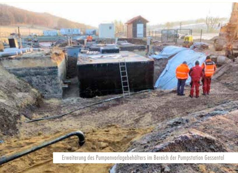
Erweiterung des Pumpenvorlagebehälters im Bereich der Pumpstation Gessental
