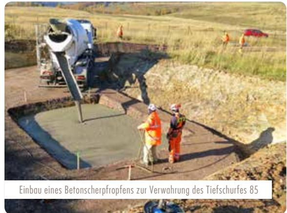
Einbau eines Betonscherpfropfens zur Verwahrung des Tiefschurfes 85
