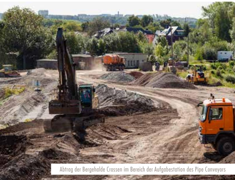
Abtrag der Bergehalde Crossen im Bereich der Aufgabestation des Pipe Conveyors
