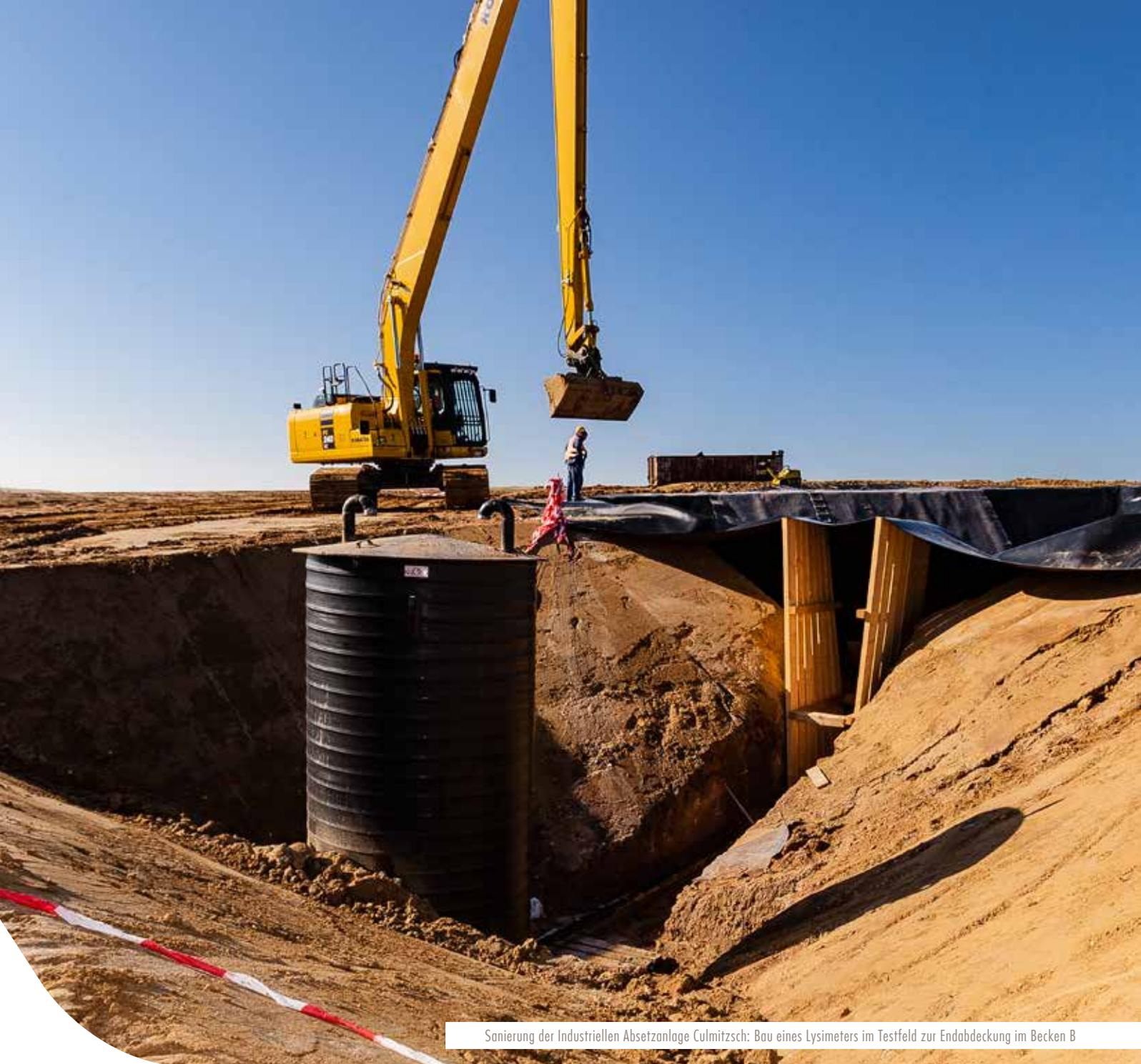
Sanierung der Industriellen Absetzanlage Culmitzsch: Bau eines Lysimeters im Testfeld zur Endabdeckung im Becken B
