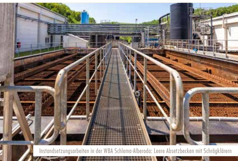
Instandsetzungsarbeiten in der WBA Schlema-Alberoda: Leere Absetzbecken mit Schrägklärern
