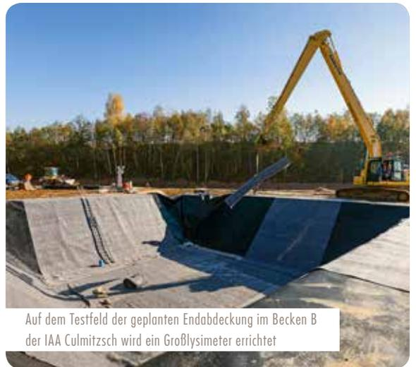
Auf dem Testfeld der geplanten Endabdeckung im Becken B der IAA Culmitzsch wird ein Großlysimeter errichtet
