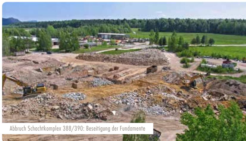
Abbruch Schachtkomplex 388/390: Beseitigung der Fundamente
