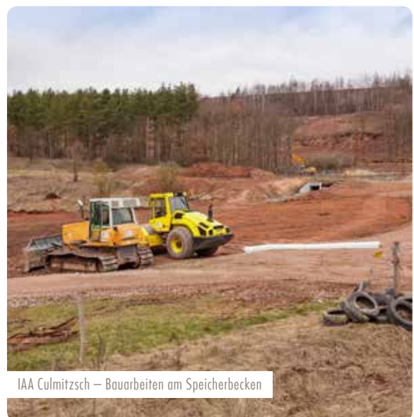
IAA Culmitzsch Becken A – Restsee und Konturierungsbereich Süd-/Südostdamm
