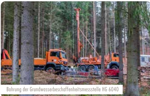
Bohrung der Grundwasserbeschaffenheitsmessstelle HG 6040
