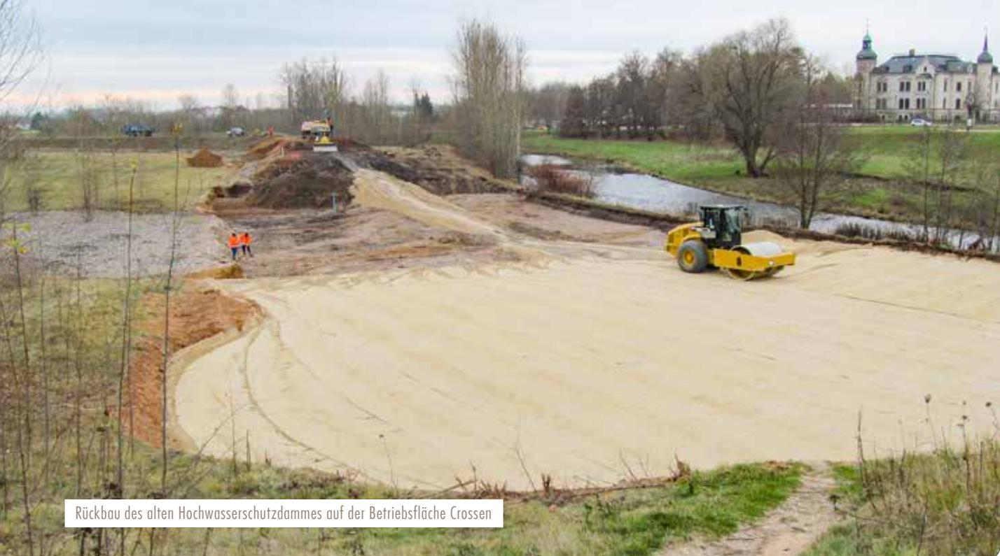
Rückbau des alten Hochwasserschutzdammes auf der Betriebsfläche Crossen
