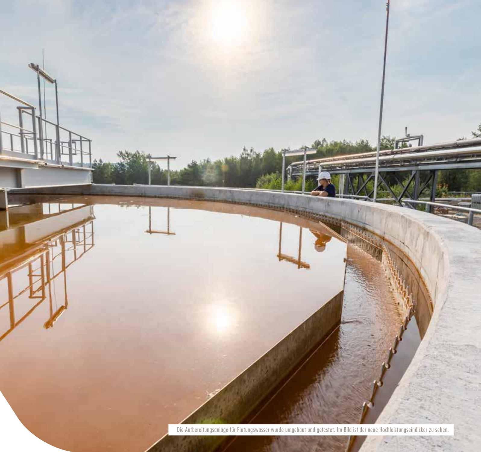
Die Aufbereitungsanlage für Flutungswasser wurde umgebaut und getestet. Im Bild ist der neue Hochleistungseindicker zu sehen.
