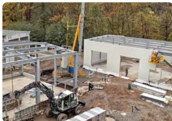
← Neubau des Lagers und der Gerätewerk- statt auf der Betriebsfläche Schacht 371
