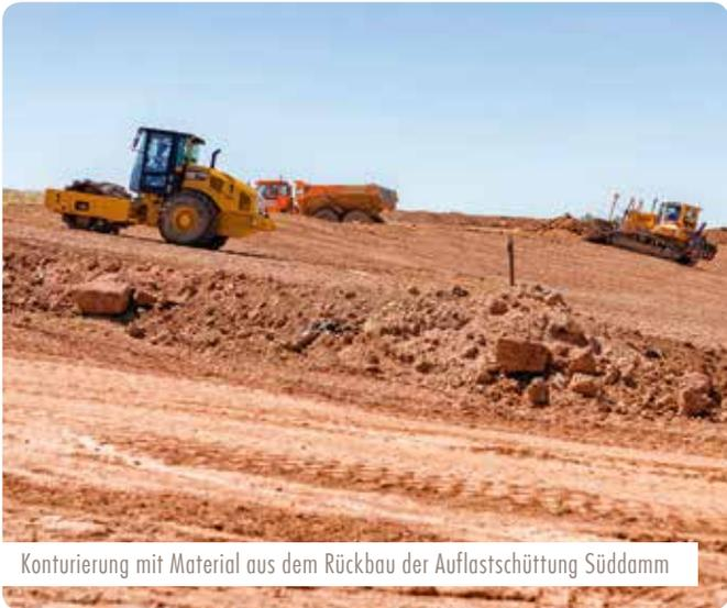
Konturierung mit Material aus dem Rückbau der Auflastschüttung Südamm
