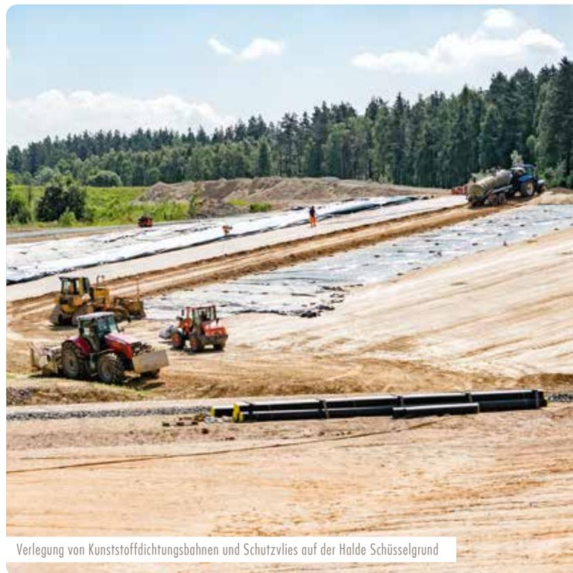
Verlegung von Kunststoffdichtungsbahnen und Schutzvlies auf der Halde Schüsselgrund
