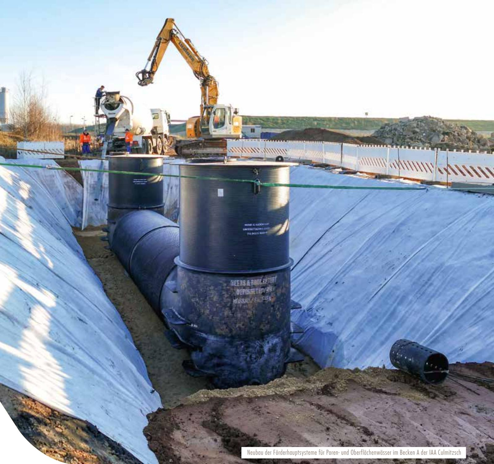
Neubau der Förderhauptsysteme für Poren- und Oberflächenwasser im Becken A der IAA Culmitzsch
