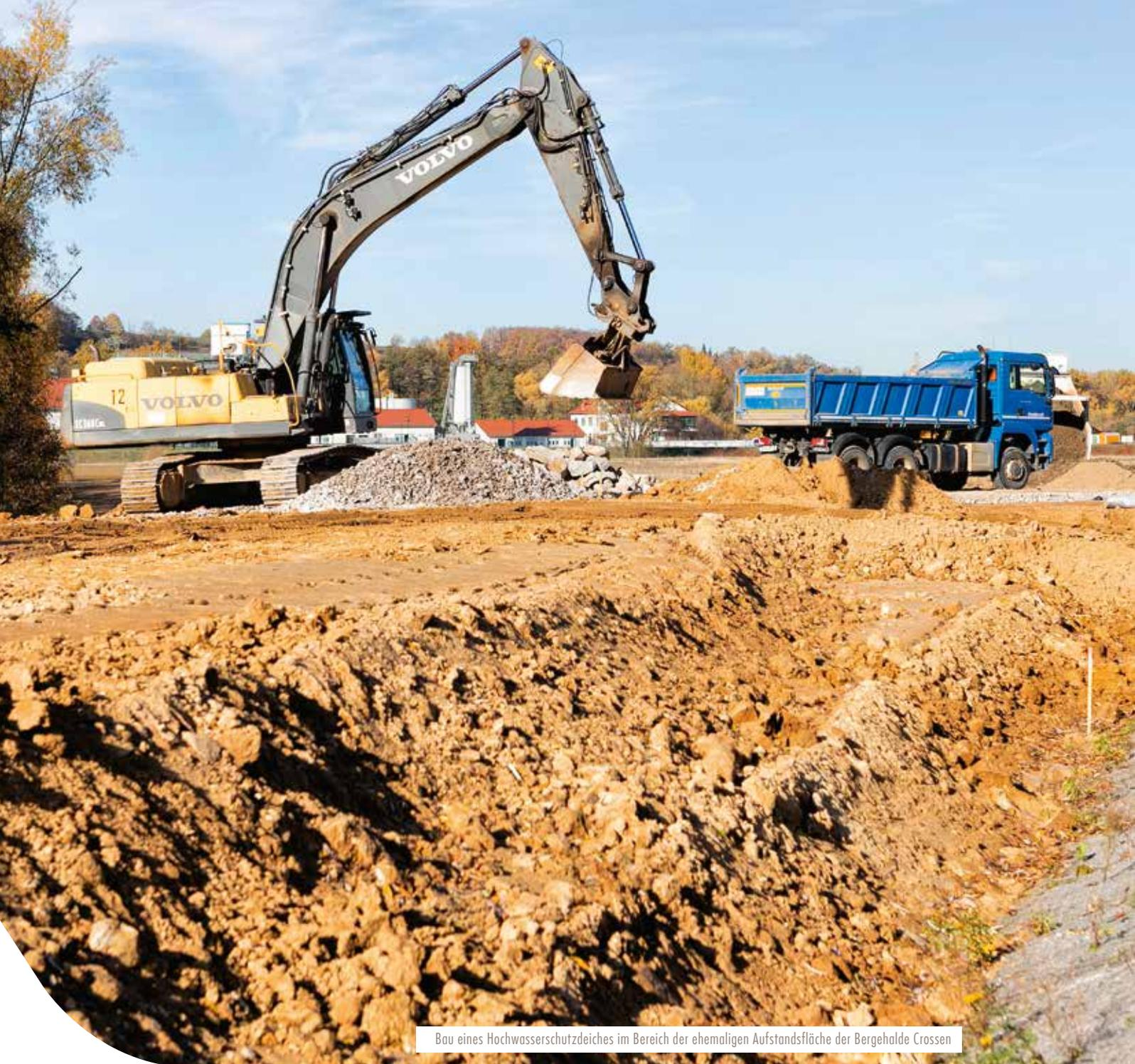
Bau eines Hochwasserschutzdeiches im Bereich der ehemaligen Aufstandsfläche der Bergehalde Crossen
