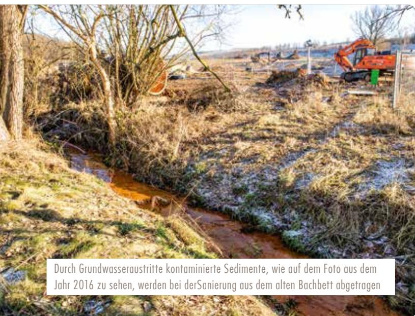
Durch Grundwasseraustritte kontaminierte Sedimente, wie auf dem Foto aus dem Jahr 2016 zu sehen, werden bei der Sanierung aus dem alten Bachbett abgetragen
