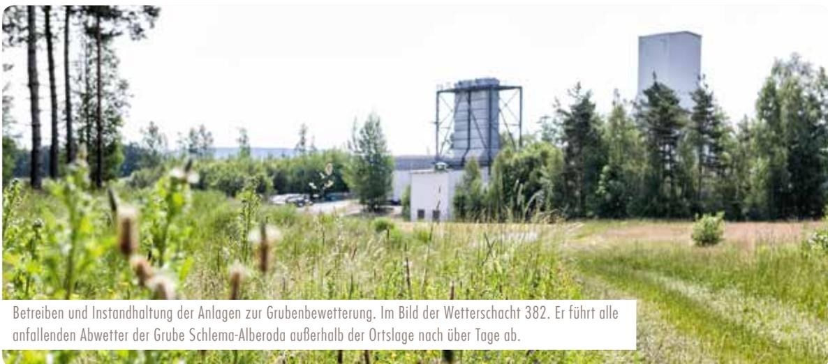
Betreiben und Instandhaltung der Anlagen zur Grubenbewetterung. Im Bild der Wetterschacht 382. Er führt alle anfallenden Abwetter der Grube Schlemm-Alberoda außerhalb der Ortslage nach über Tage ab.
