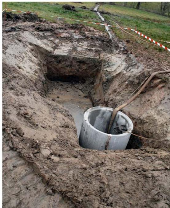
Bild 6.1-3 Fassung und Ableitung dieser Wässer in einen Pumpschacht, Dezember 2006
