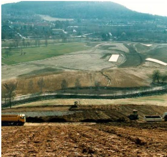
Bild 2.1-6 Standort Schlema-Alberoda, Hammerberghalde, Auftrag von Mineralboden und Mutterboden zur Rekultivierung, im Hintergrund Deformgebiet 1, März 1992
