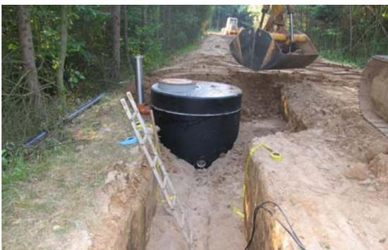
Bild 4.1-5 Standort Königstein, Bau des Wasserfassungssystems zur Trennung der Sickerwässer von den Oberflächenwässern auf der Halde Schüsselgrund, Oktober 2006
