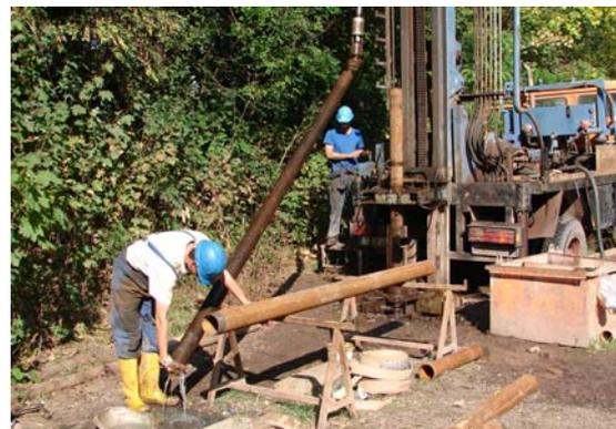
Bild 5.1-5 Steinbruch Osterberg, Entnahme des Bohrkerns aus dem Kernrohr, September 2006
