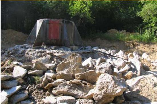
Bild 4.1-2 Standort Königstein, Fundamentabbruch am Wetterbohrloch 1
