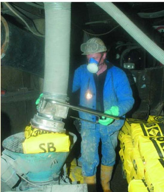
Bild 2.3-1 Sanierungsarbeiter beim Befüllen einer Betonspritzmaschine während des Einbaus eines Absperrdammes, Oktober 2005
