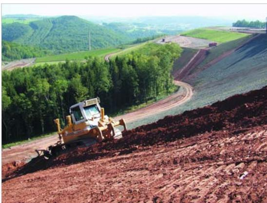
Bild 2.1-4 Auftrag von Abdeckmaterial auf die Nordböschung der Halde 382 West, September 2005
