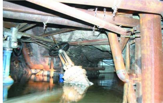
Bild 2.1-3 Flutungswasserleitung in der teilgefluteten Wasserstrecke der -60-m-Sohle, August 2005
