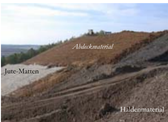
Bild 2.5-6 Sanierung Halde 381 - Ausschnitt
