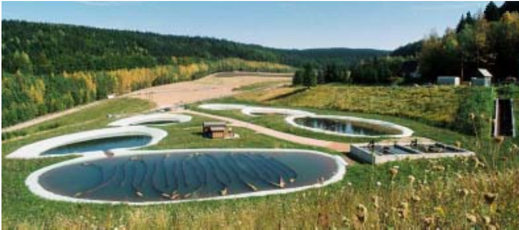
Bild 2.2-2 Constructed Wetland in Pöbla mit profilierter Luchsbachhalde im Hintergrund, September 2004
