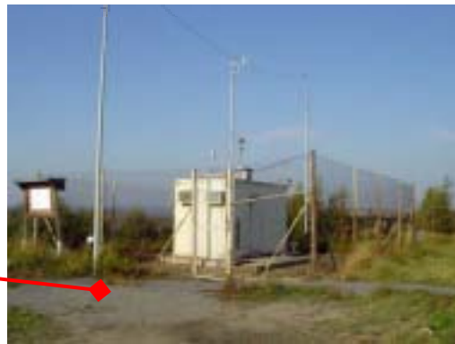
Bild 4.2.2-10 Meßcontainer für Luftpfad am Schutzdamm Tagebau Lichtenberg OT Friedrichshaide
