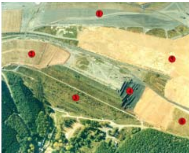
Bild 2.6-1 NLR (Crossen) - IAA Helmsdorf, Abtragsarbeiten Hauptdamm 1 – Südlicher Höhenrücken 2 – Pipe Hügel 3 – Hauptdamm 4 – Hauptdammantrag Baulos 1/2 5 – Ostbühgel 6 – Norddamm
