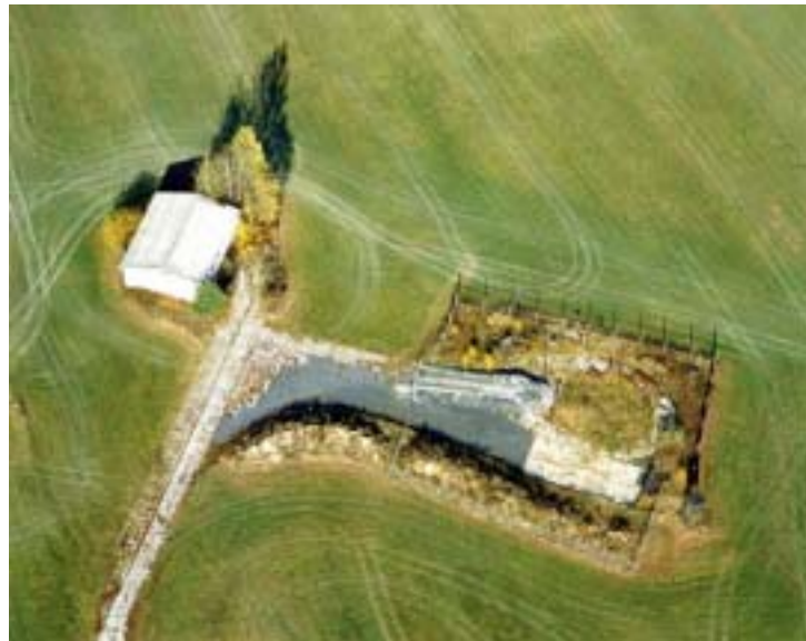
Bild 3.2-1 Standort Königstein, Wetterschacht 392 nach der Verwahrung, November 2003
