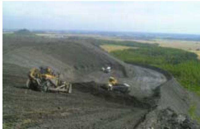
Bild 2.5-2 Rampe und Abtragsort Kegelbalden Reust: Beginn der Umlagerung, August 2004
