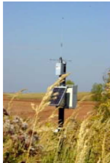
Bild 2.7-7 Meßwertsammelstation für Porenwasserdruckgeber im Bereich Baulos I/2 der Konturierung LAA Trünzigg, Oktober 2004
