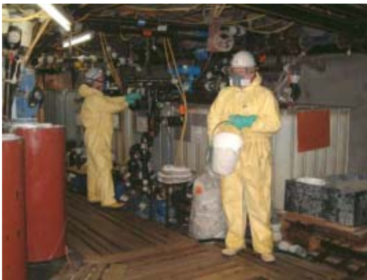
Bild 2.3-1 Arbeiten zur Schadstoffimmobilisierung im Grubenfeld Süd
