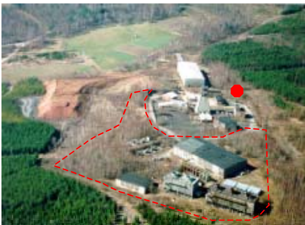
Bild 3.1-1 Standort Schlema-Alberoda, Teilfläche 2 des ehemaligen Betriebsgeländes Schacht 382 vor der Sanierung, 1995
