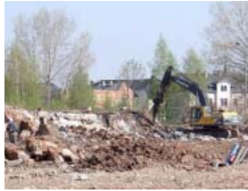
Bild 2.6-4 Fundamentabbruch auf dem ehemaligen Werksgelände Crossen, März 2004
