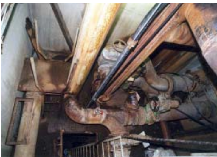
Bild 2.1-3 Blick ins UG 212 mit der alten Flutungswasserleitung von der -60-m-Sohle zur WBA Schlema-Alberoda, Juli 2004
