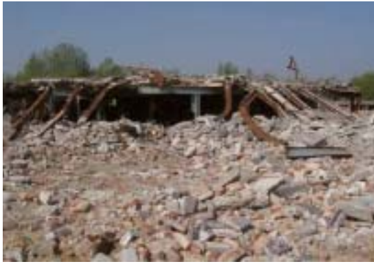
Bild 2.6-3 Massive Stahlkonstruktionen auf dem ehemaligen Werksgelände Crossen, März 2004
