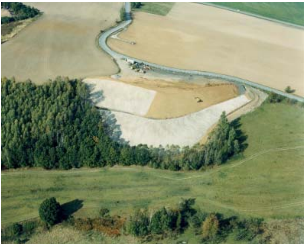
Bild 3.3-3 Standort Ronneburg, Abdeckerarbeiten Halde 381, Oktober 2004
