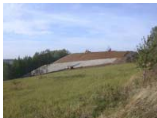
Bild 2.5-7 Sanierung Halde 381 - Gesamtansicht
