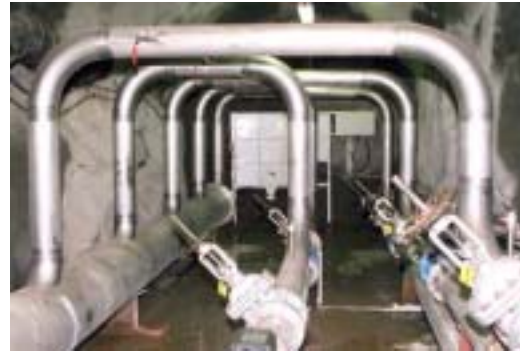
Bild 2.1-2 neu fertiggestellte Schieberkammer auf Höhe Markus-Semmler-Sohle im Schacht 208, Juli 2004
