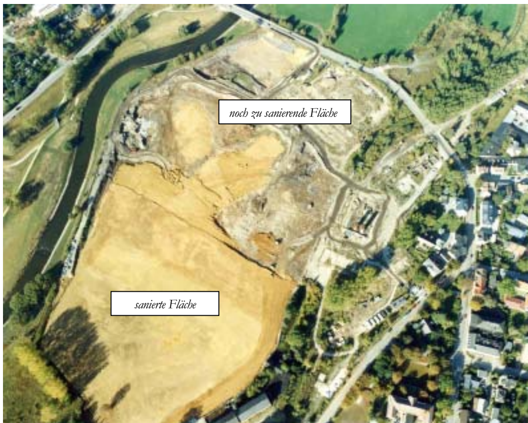
Bild 2.6-5 Flächensanierung Betriebsfläche Crossen, Oktober 2004
