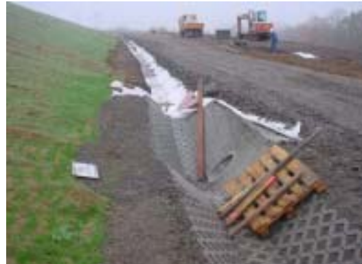
Bild 2.4-3 Wasser- und Wegebau auf der Bergehalde Gittersee - Wasserdurchlaß zur Ableitung in das Gerinne des nächsten Wirtschaftsweges bis zum Vorfluter
