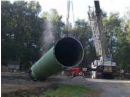
Bild 2.3-2 Demontage Aufrobrung am Wetterbohrloch 2
