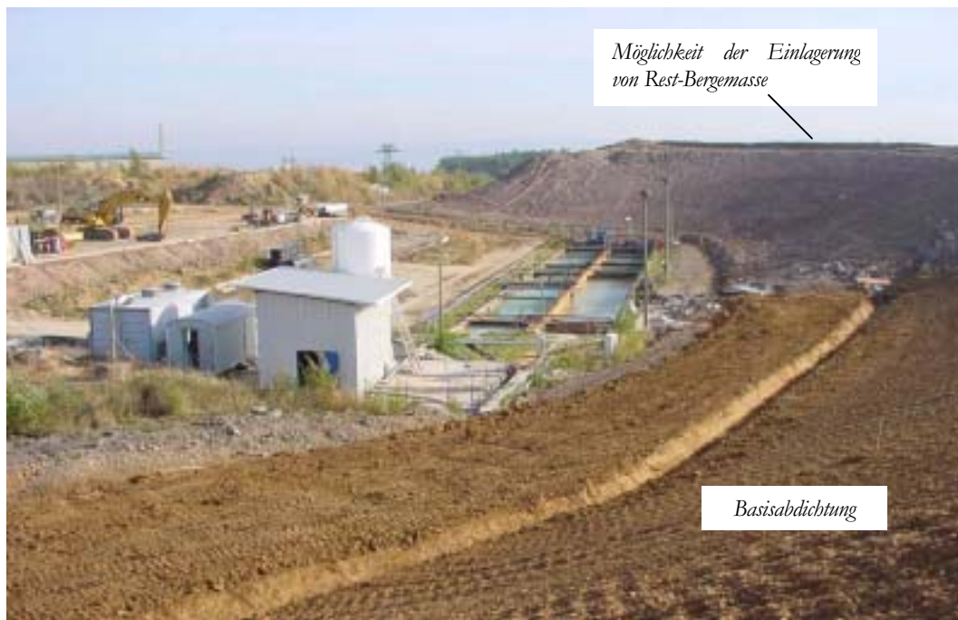
Bild 2.4-1 Bau der Basis der 2. Haldenerweiterung Bergelalbe Gittersee (Dämmschicht incl. anlegen Drainagesystem), erneuerte Kalkmilchdosieranlage sowie Absetzbecken, wo das Wasser aus dem Förderbohrloch 1 behandelt und anschließend in die Vorflut abgegeben wird
