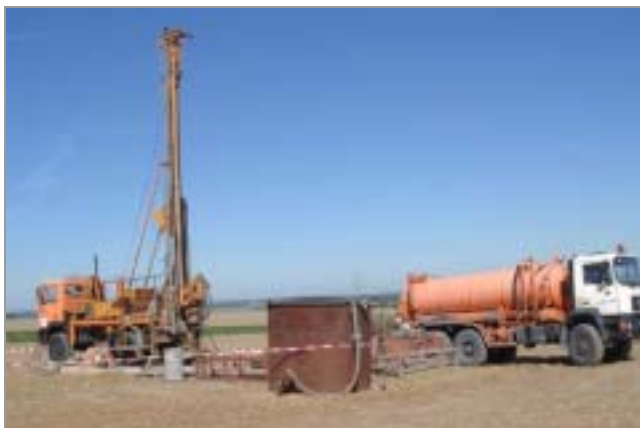
Bild 4.2.1-16 Reinigung einer Grundwassermeßstelle links Bobrvagen mit Bobrgerät mitte Sammelbehälter zur Aufnahme des Wassers vom Pumpversuch rechts Wasserwagen bringt abgepumptes Wasser zur Wasserbehandlung
