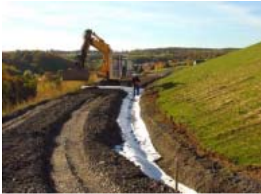
Bild 2.4-2 Wasser- und Wegebau auf der Bergehalde Gittersee
