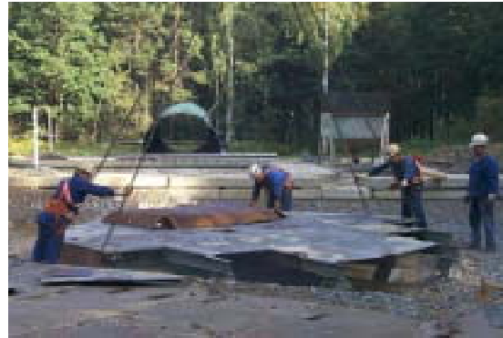
Bild 2.3-3 Montage der Abdeckung für die Verfüllung am Wetterbohrloch 2
