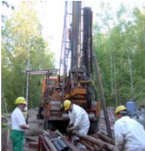
Bild 2.7-2 Erkundungsbohrung, IAA Culmitzsch
