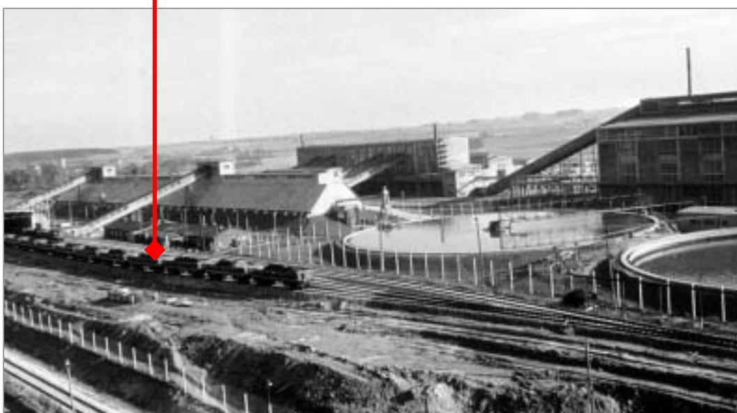
Bild 3.4-3 Bahnentladung und Erzbunker mit Bandbrücken und Eindicker im Aufbereitungsbetrieb Seelingstadt, 1960
