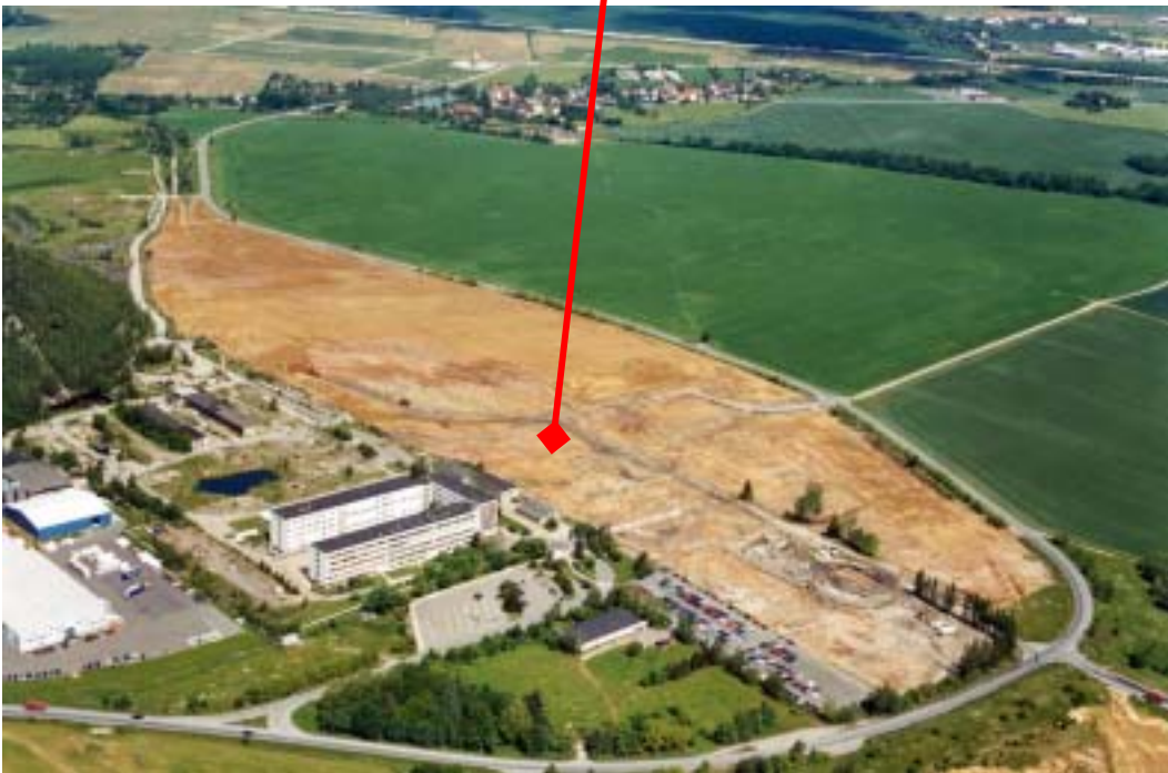
Bild 3.3-2 Standort Ronneburg, sanierte Betriebsfläche Paitzdorf, nordöstlicher Teil, Juni 2004
