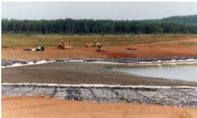
Bild 2.7-3 Freigefallene Spülstrandbereiche auf der IAA Culmitzsch A
