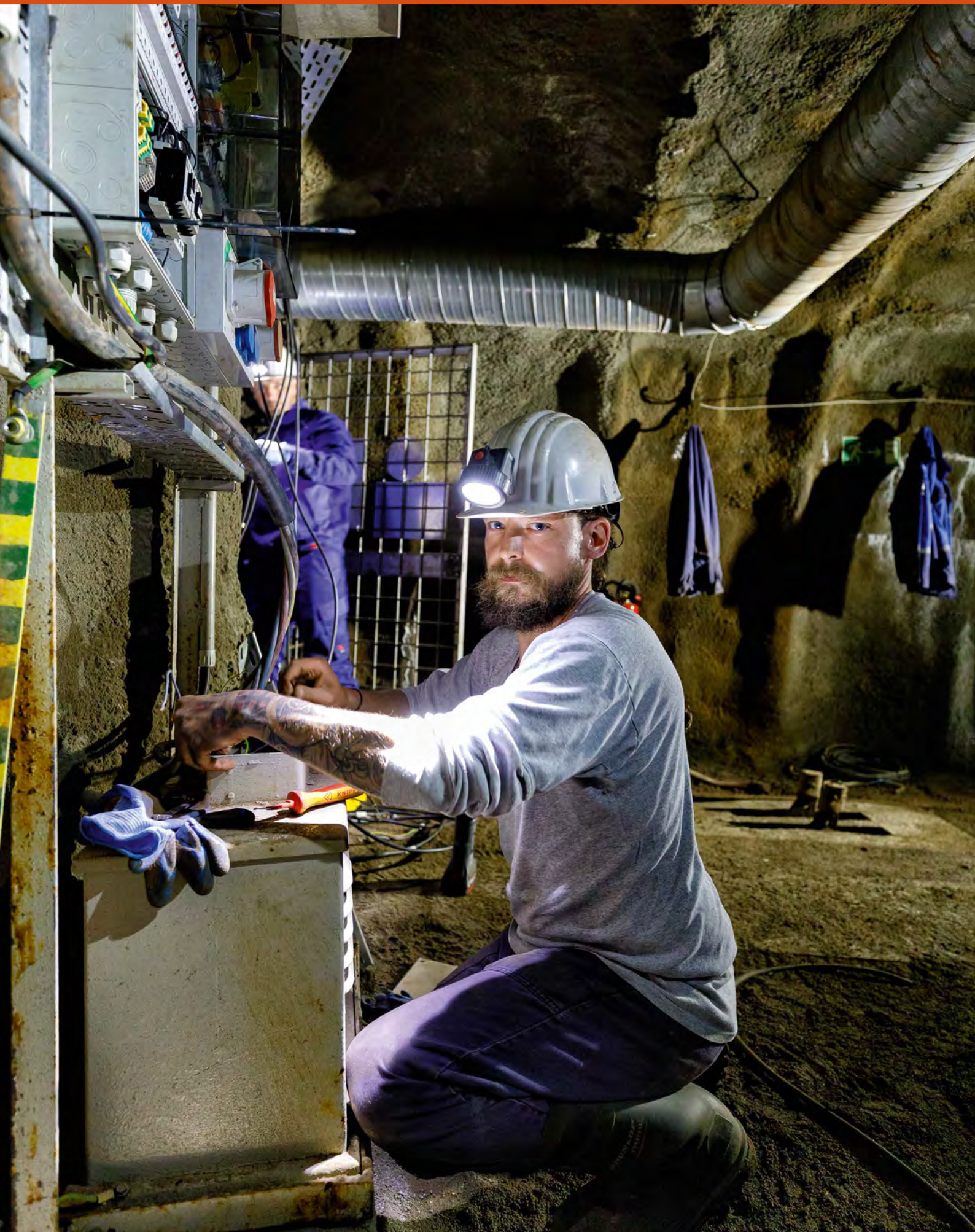
44 Elektriker David Engert baut mit Kollegen nach der Reko der Strecke 2 auf der Markus-Semmler-Sohle in Bad Schlema am Zugang zum Sprengmittellager die Elektroinstallation wieder auf
