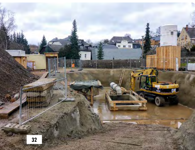
32 Baugrube am Schacht 25 mit betoniertem Schachtkragen Ende Februar 2022
