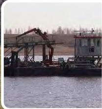
Subaquatische Abdeckung auch im Becken A der IAA Culmizsch, da die Schlämme nicht tragfähig sind
