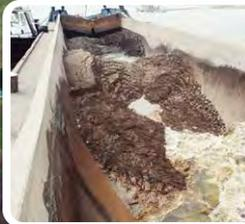
Subaquatische Abdeckung von einer schwimmenden Klappschute aus und Beginn der Konturierung der IAA Helmsdorf
