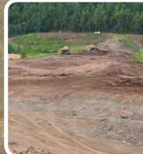
Konturierung des Norddamms der IAA Culmitzsch; Endabdeckung Dänkritz I fertig
