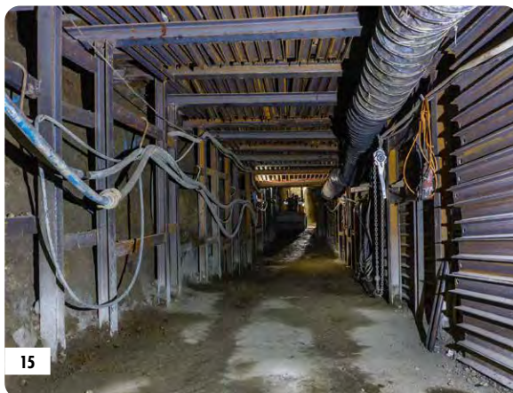
15 Sicherung der Streckenaufwältigung mit Stahlausbau und Getriebezimmern, Ende 2019
