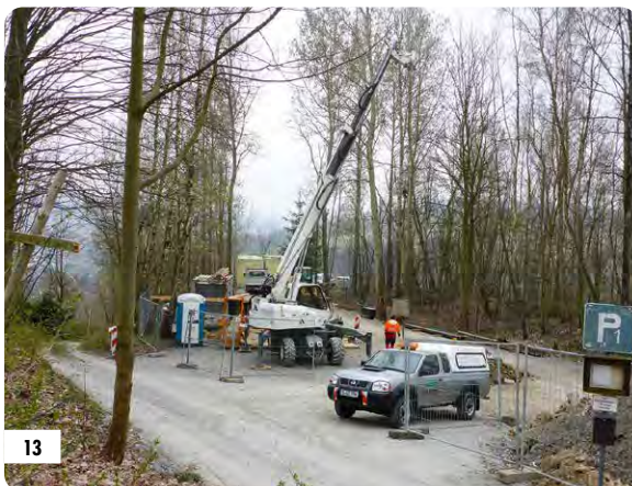
13 Zugangsteufe im Sanierungsbereich Mitte, April 2019
