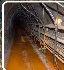
Errichtung der Flutungsstollen in Königstein
