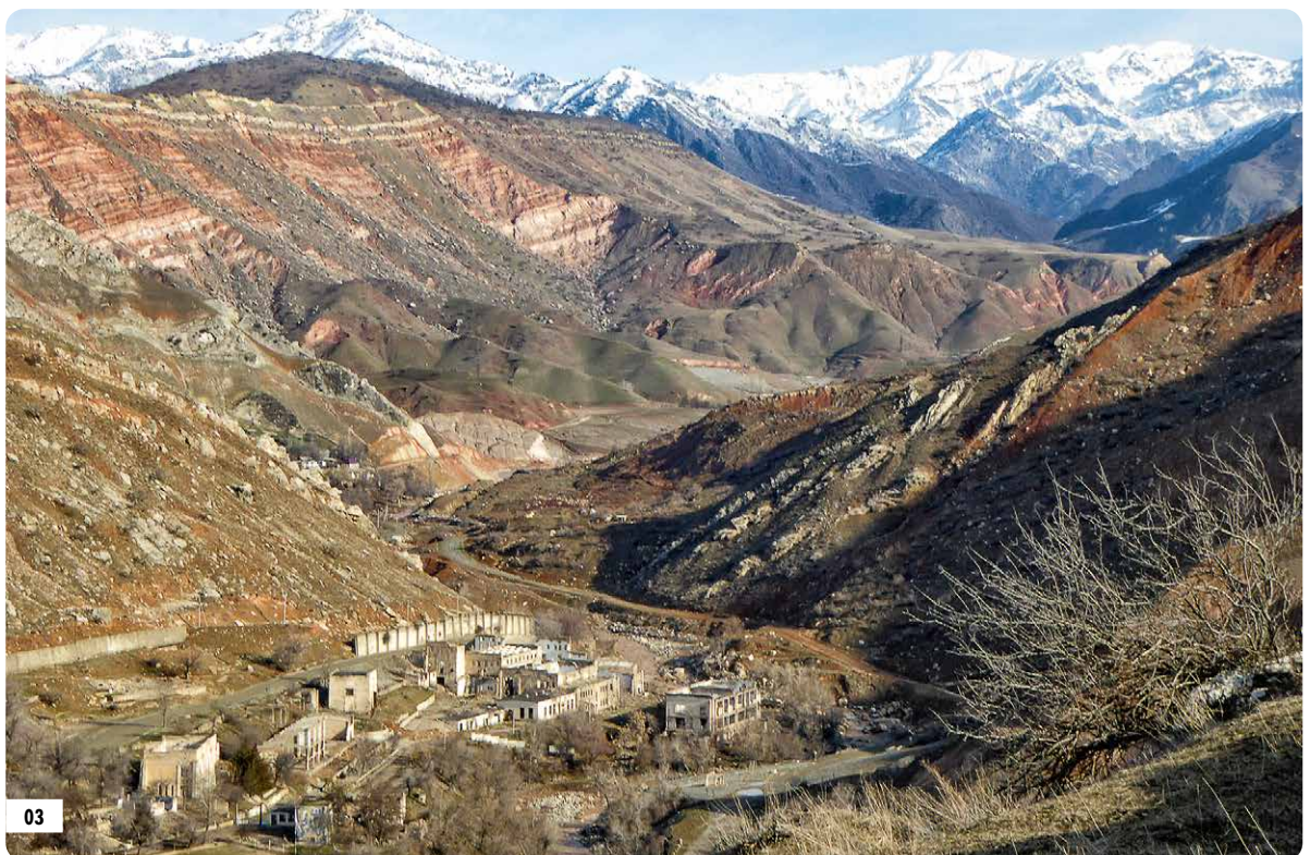
03 Ehemalige Uranerzaufbereitung (Isolitfabrik, Blick flussaufwärts nach Norden, März 2019)
