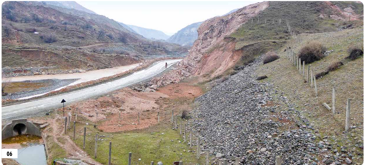
06 Damm der Absetzanlage TP 5 am Mailuu-Suu-Fluss
