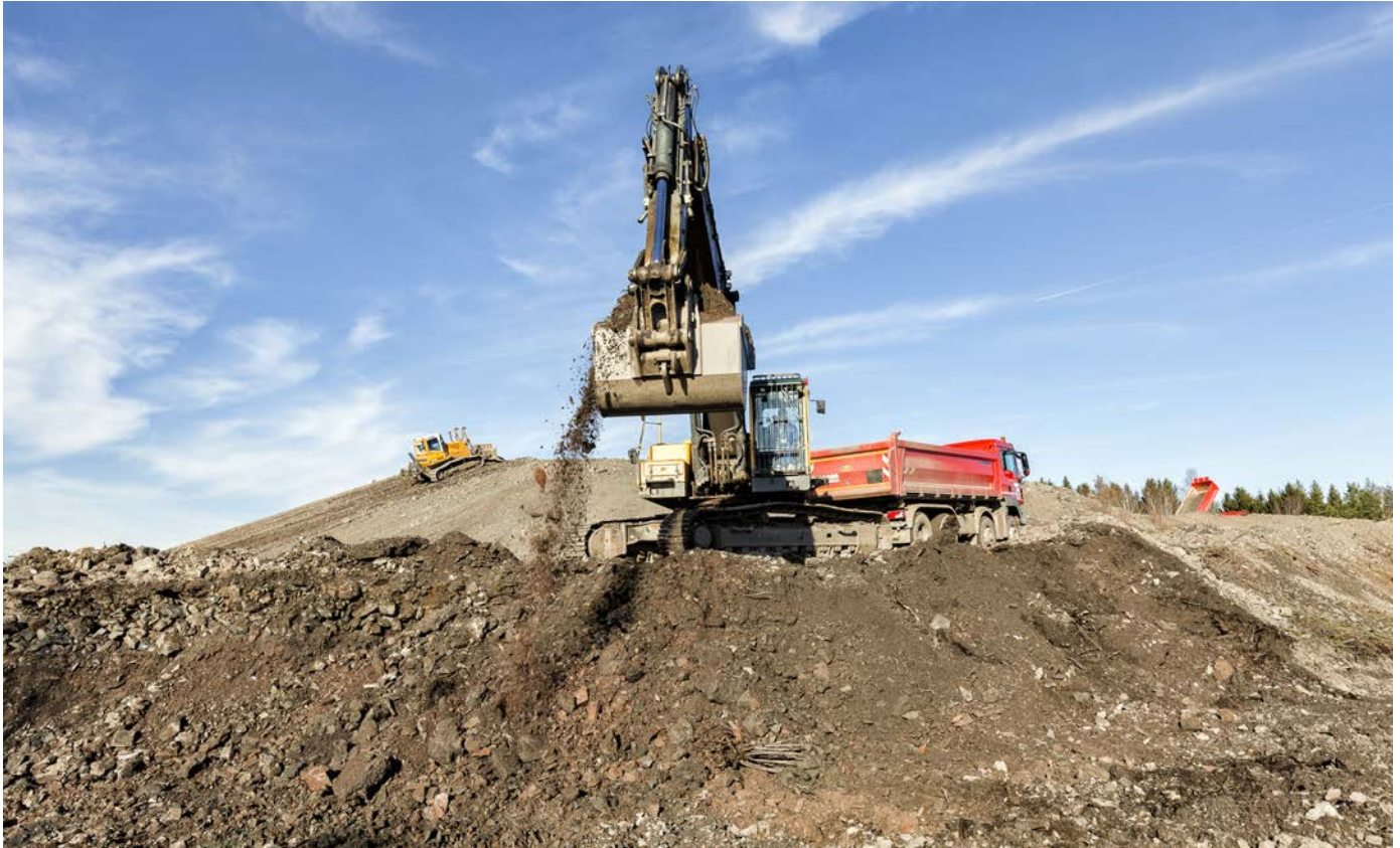
In-situ-Verwahrung der Halde 310 in Bad Schlema (2014)
