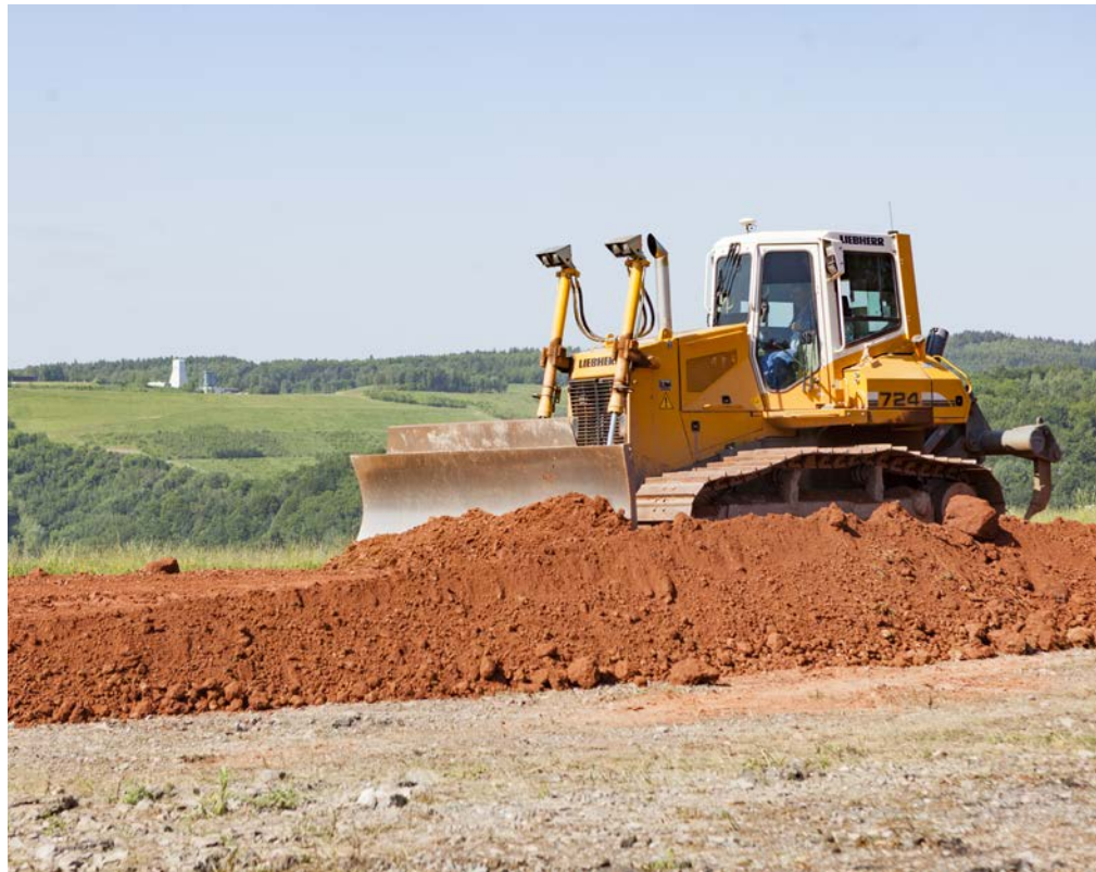
Endabdeckung der Halde 371/II am Standort Aue (2015)
