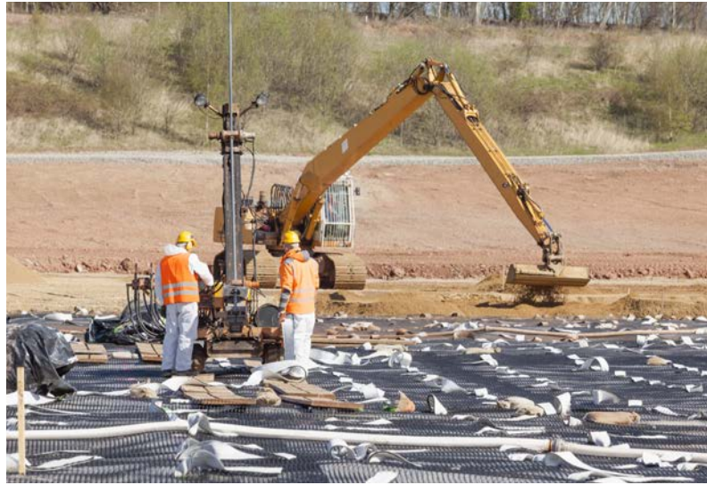
Aufbau der Zwischenabdeckung auf der IAA Culmitzsch (2016)
