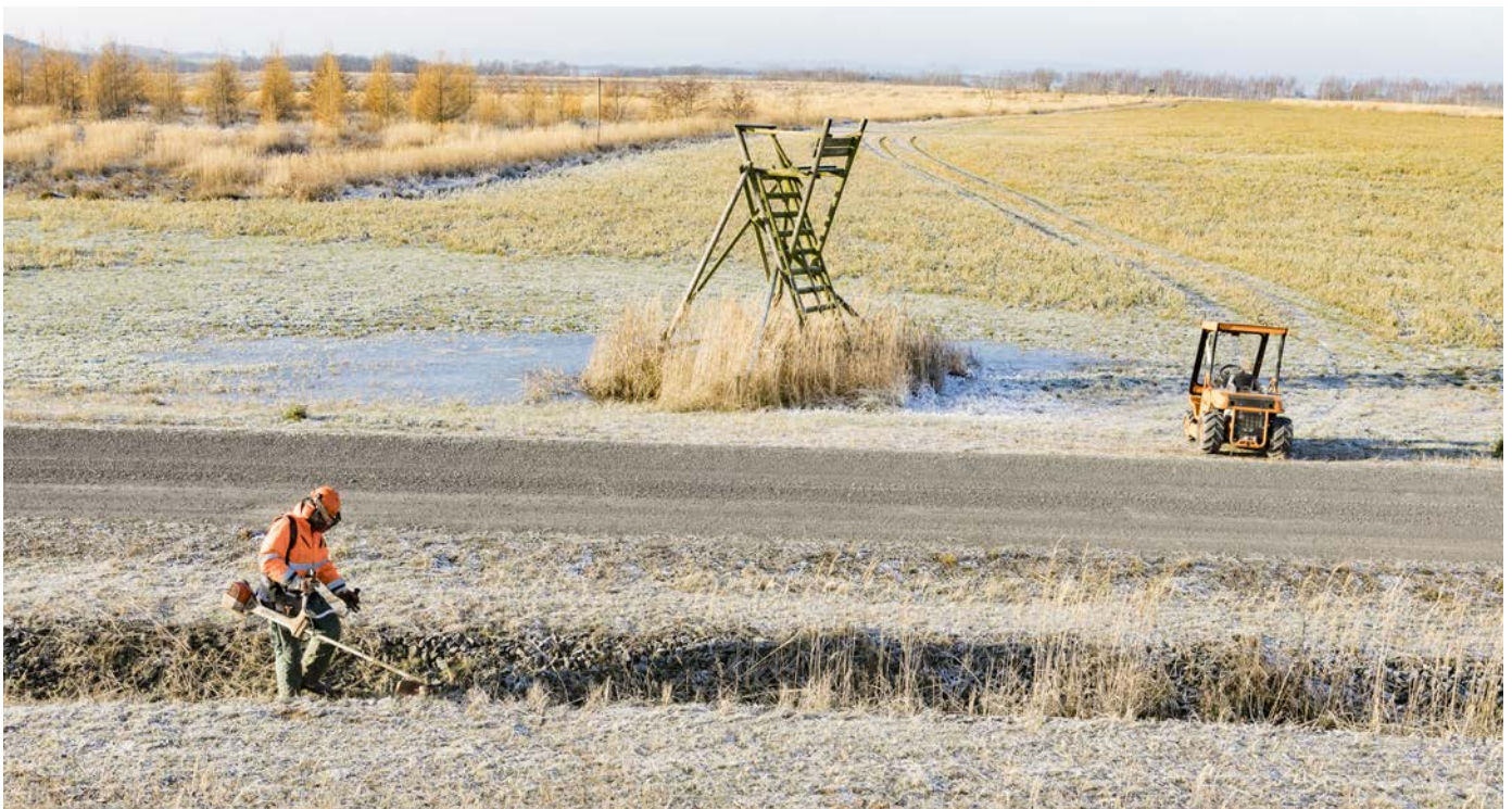
Freihalten der Wassergerinne des Aufschüttkörpers Tagebau Lichtenberg (2016)
