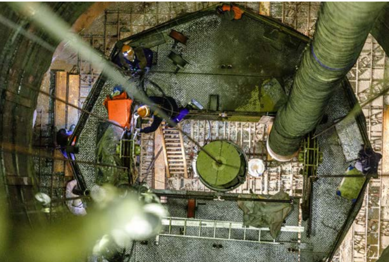
Verwahrung des Schachts 208, 2023
