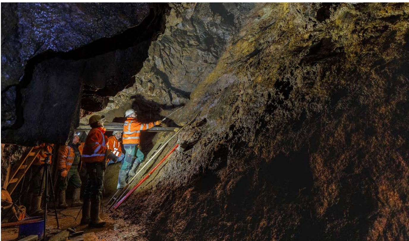
Verwahrung im Revier am Rabenberg in Breitenbrunn (2023)
