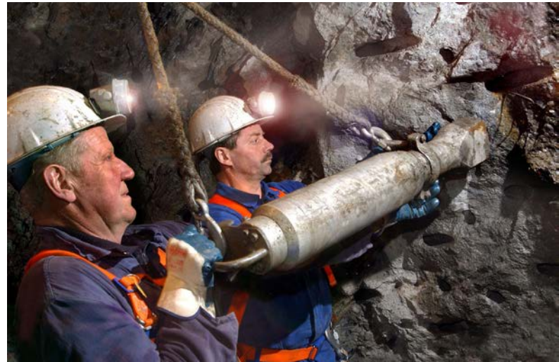
Untertägige Sanierungsarbeiten im Grubenfeld Schlema-Alberoda (2003)
