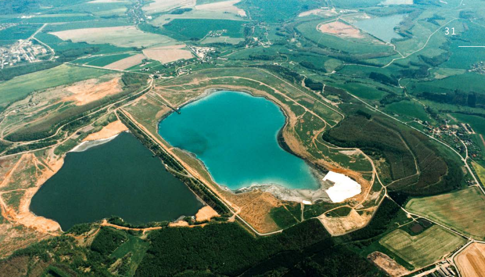
Absetzanlagen Culmitzsch und Trünzig dahinter (1995)
