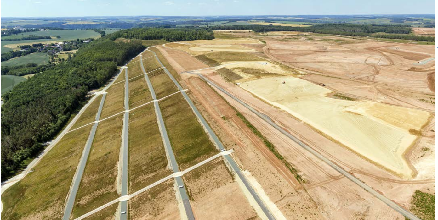
Endabdeckung einer Teilfläche im Becken A der IAA Culmitzsch, 2022
