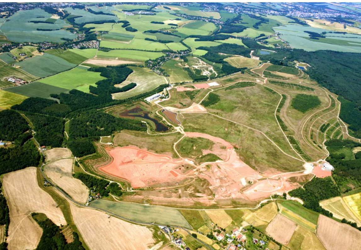
Absetzanlagen Helmsdorf und Dänkriz I (2022)
