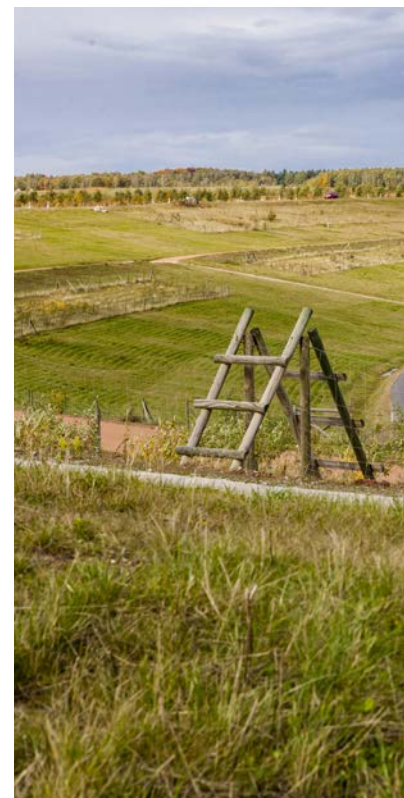
Hauptdamm der industriellen Absetzanlage Helmsdorf (2013)
