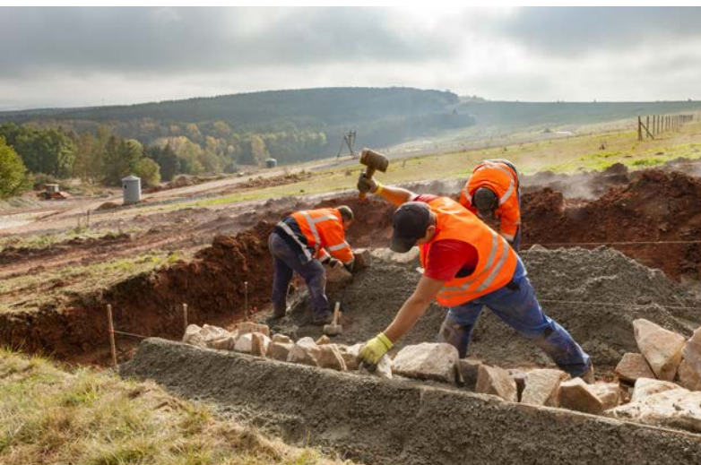
Bau von Gerinnen auf dem Hauptdamm (2011)
