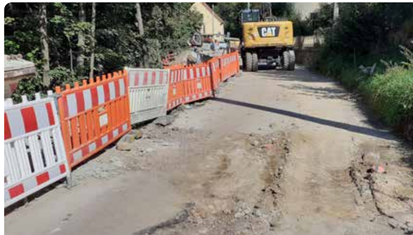
GBV Stollen Scharfenberg, Erkundungsbohrungen auf dem Wismut-Stollen, 2021
