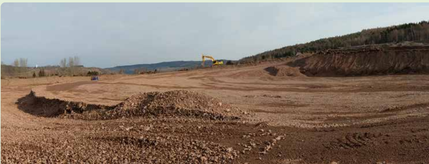
↓ Aue-Bad Schlema, Halde 65: Profilierung der Halde
