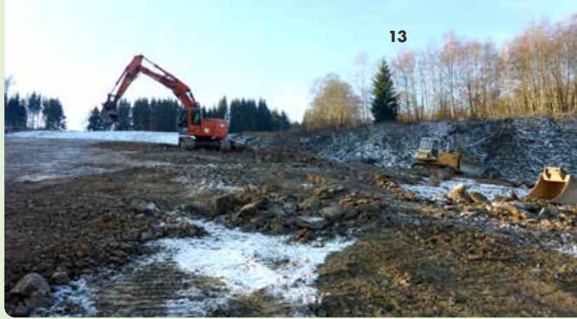
↑ Johannegeorgenstadt, Objekt 98: Beseitigung radioaktiver Kontamination
