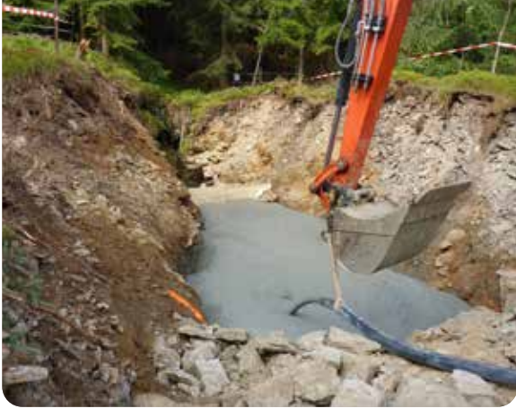
↑ Breitenbrunn, Bereich Schacht 206: Betonage einer Schadstelle, unmittelbar neben einer öffentlichen Straße (Bild links und rechts)
