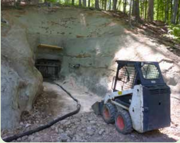
↑ Lauter-Bernsbach, Revier Lauter: Verwahrung Stolln 5
