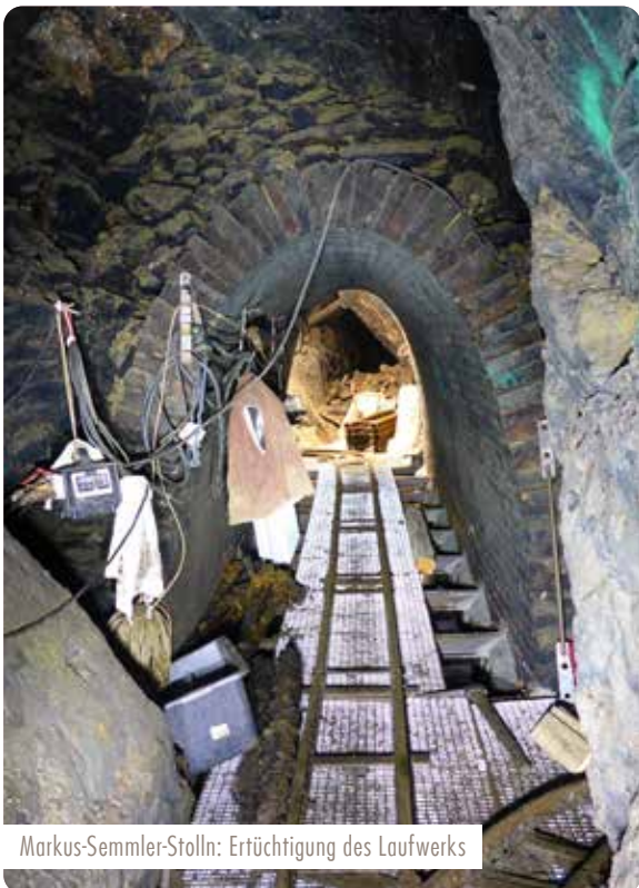
Markus-Semmler-Stolln: Einbauten zur Sicherung und Vorbereitung der Sohlbetonage
