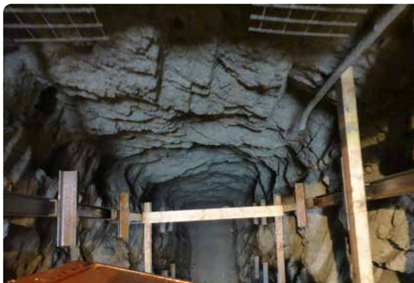
Grubenfeld 98: Aufwältigung und Sicherung von Schacht 318
