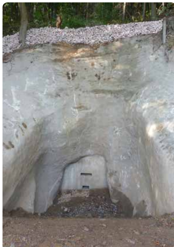
← Revier Lauter: Stolln 4 mit Öffnungen für Fledermäuse und Amphibien
