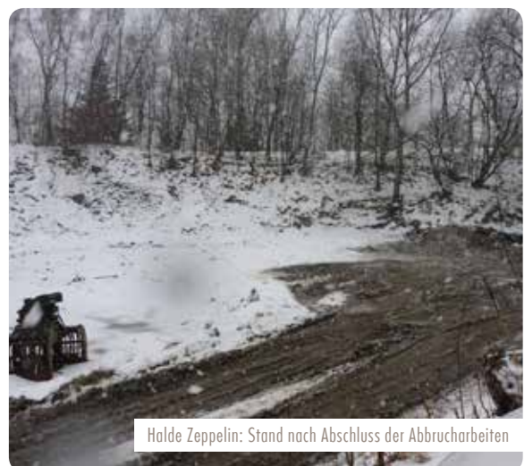
Halde Zeppelin: Abbrucharbeiten
