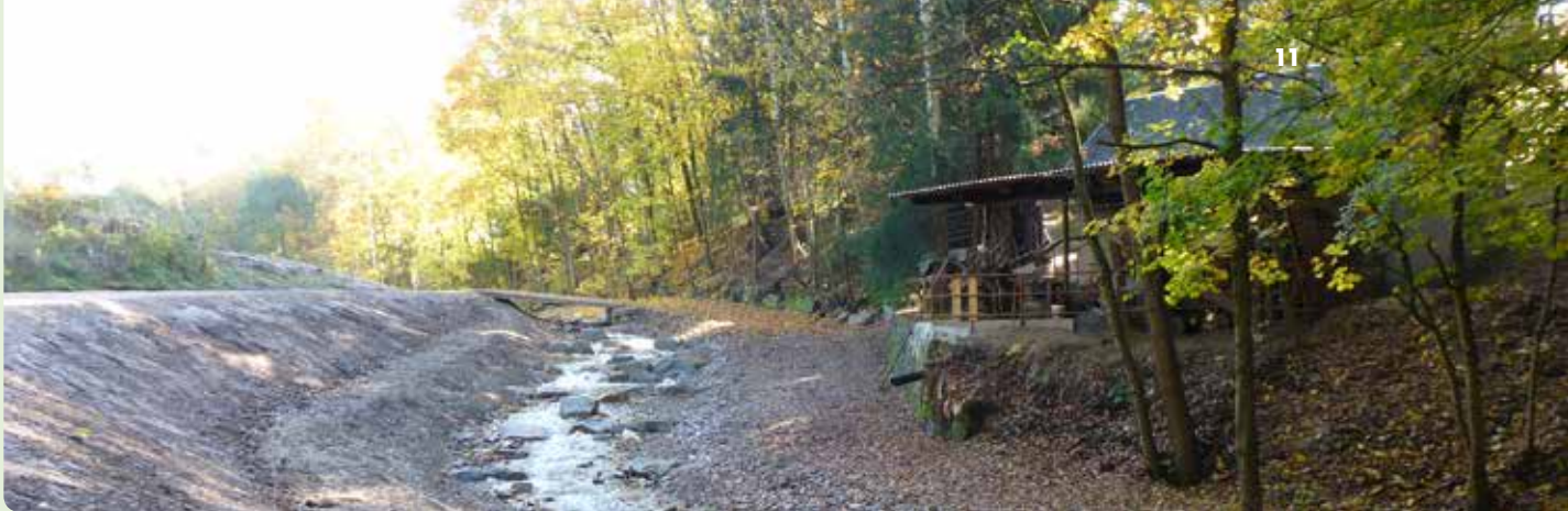
↑ Sanierter Plohnbach oberhalb des Lenckteiches (Hochwasserschadenbeseitigung)
