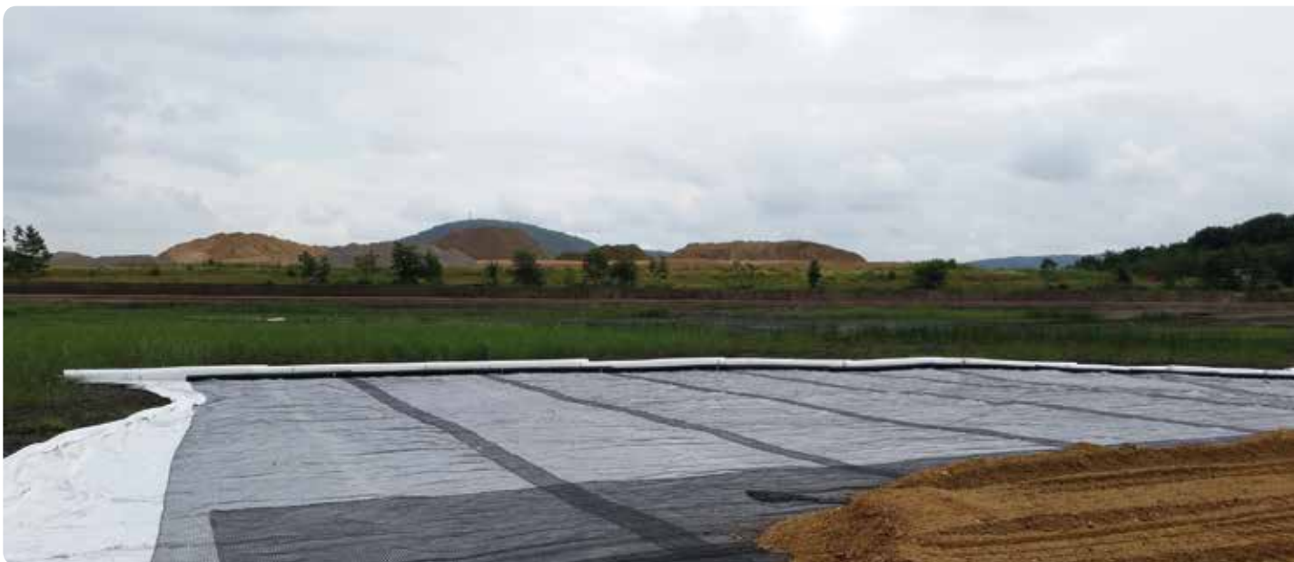
↑ IAA Teich 4, Freital: Überdeckung des radioaktiven Feinschlammes mit Geotextil und Geogitter
