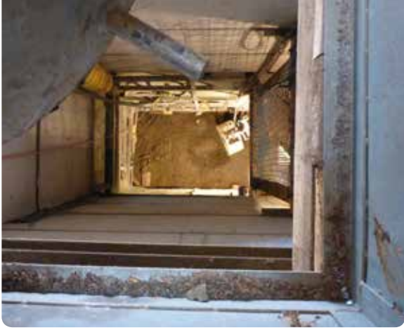
↑ Aufwältigung Schacht 322, Mildenau
