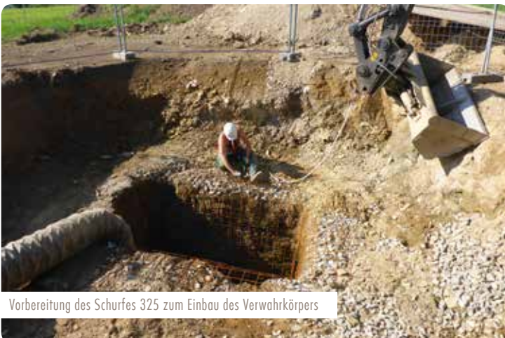
Verwahrkörper im Bereich der Schadstelle Überhauen 7331/1
