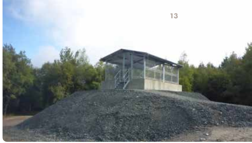
↑ Umhausung Schacht 281, Oberwiesenthal
