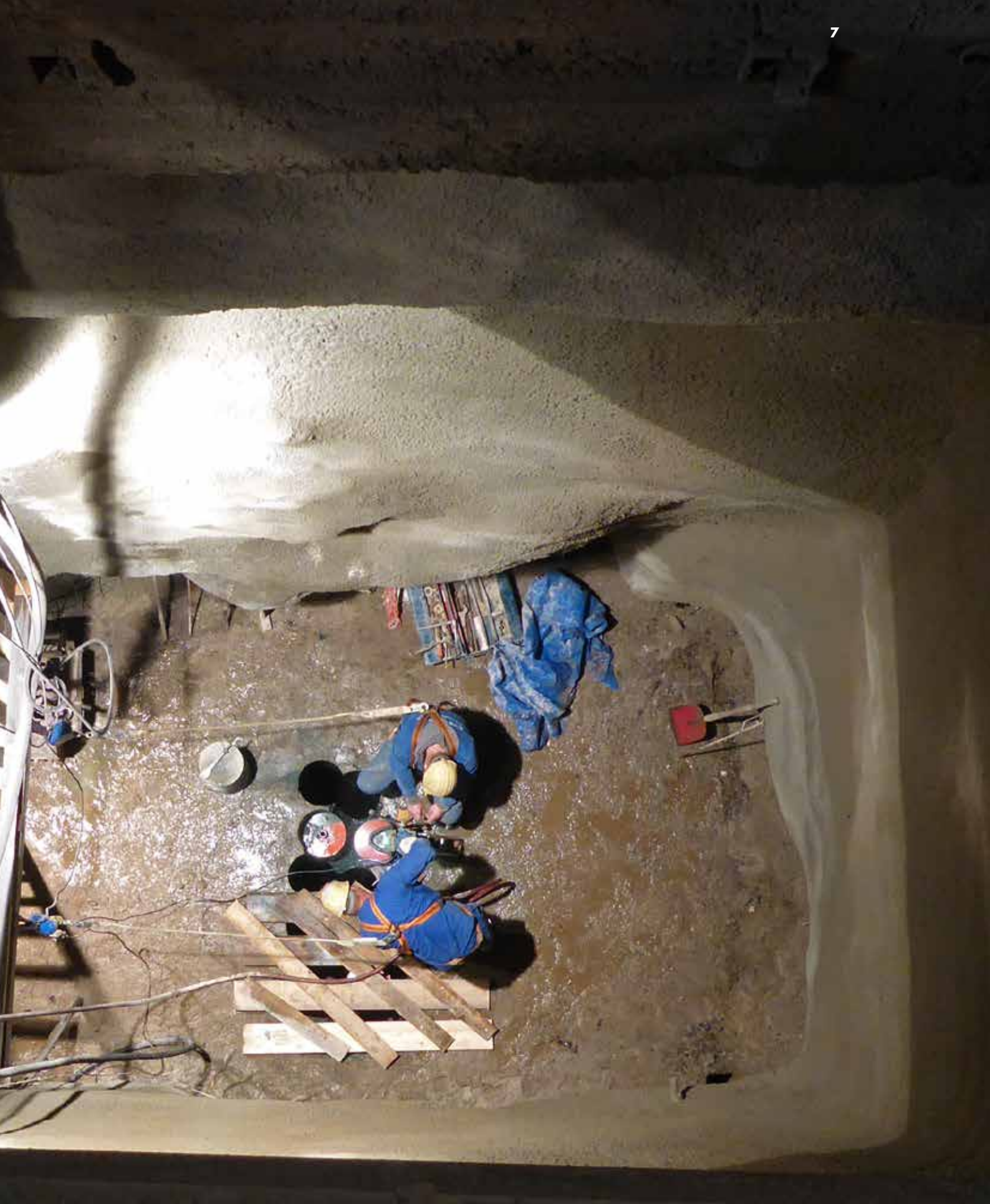
Schacht 281 in Oberwiesenthal: Durchbrechen der alten Schachtsicherung
