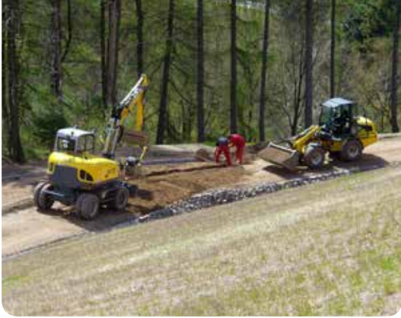
↑ Arbeiten an der Halde 54 in Johanngeorgenstadt
