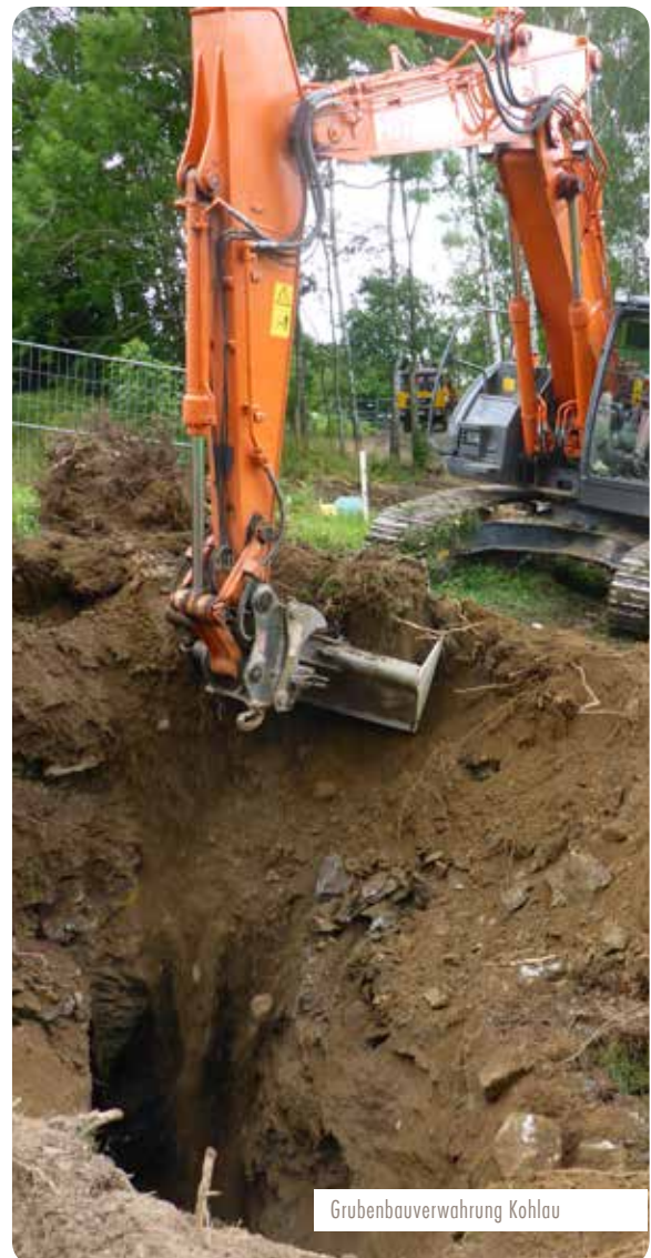
Vorbereitung von Sprengarbeiten zur Herstellung der Teufe
