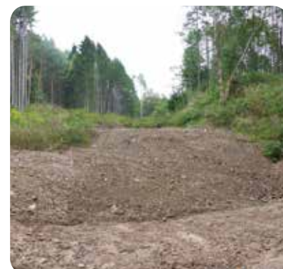
Gang 57/57a, 1. Bauabschnitt, Raschau-Markersbach
