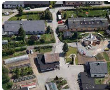
Tagesbruch Dörfler Weg, Annaberg-Buchholz
