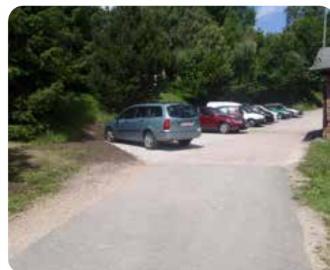
Tagesbruch Alter Mühlberg, Schneeberg
