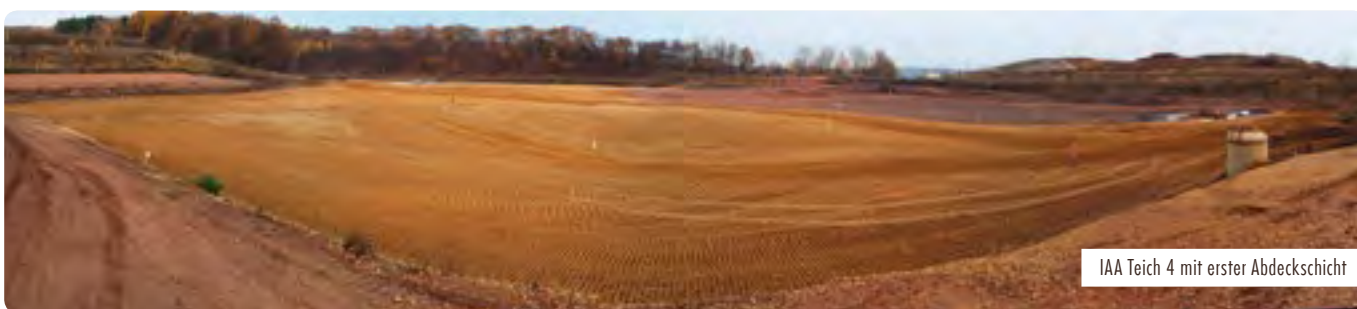
IAA Teich 4 in Freital vor der Sanierung
