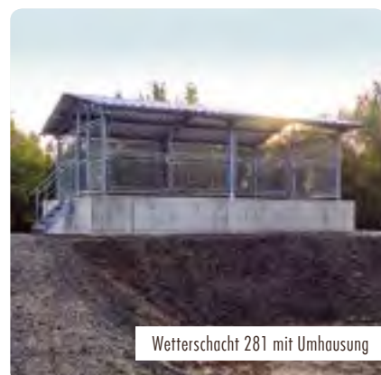
Neu errichteter Schachtkopf
