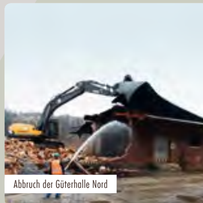
Separierung der Abbruchmassen
