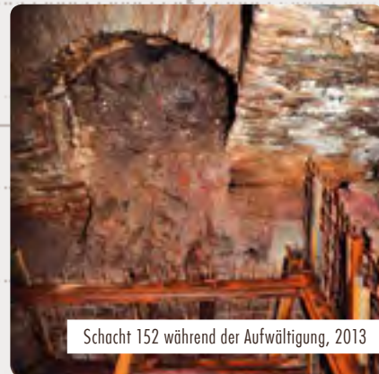
Reparatur des von der SAG Wismut zerstörten Mauerwerkes
