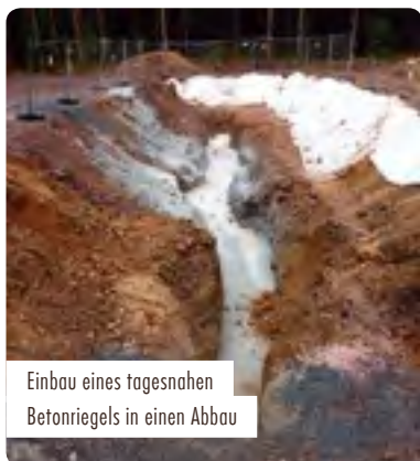
Verfüllung eines Überhauens in Kirchberg
