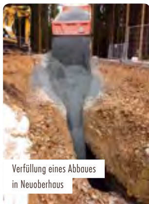
Einbau eines tagesnahen Betonriegels in einen Abbau
