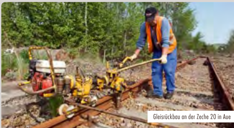
Abbruch im Bereich der Zeche 20 in Aue
