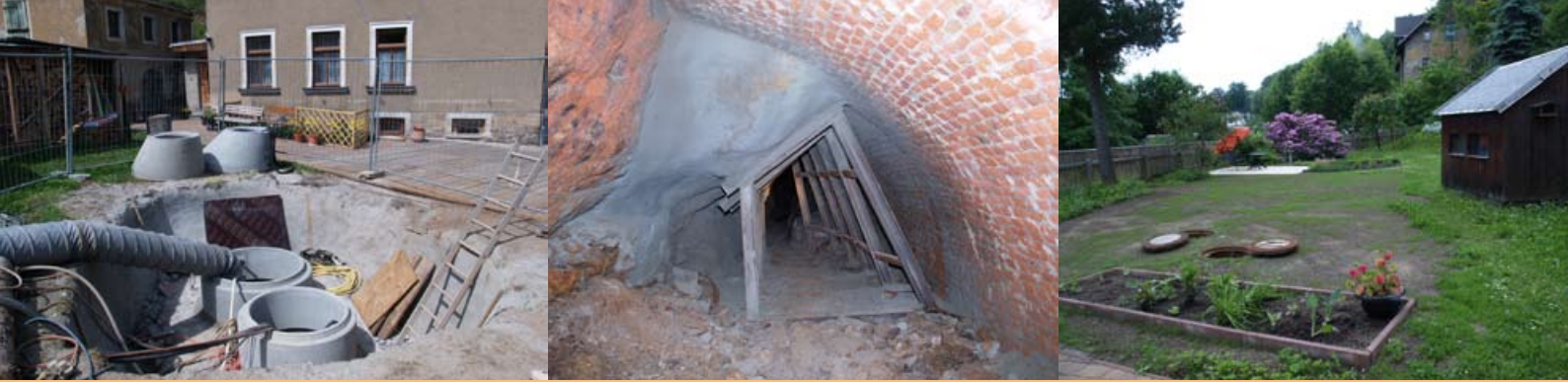
Sicherung des Bierschnabelstollns (Lichtloch 3), Annaberg-Buchholz
