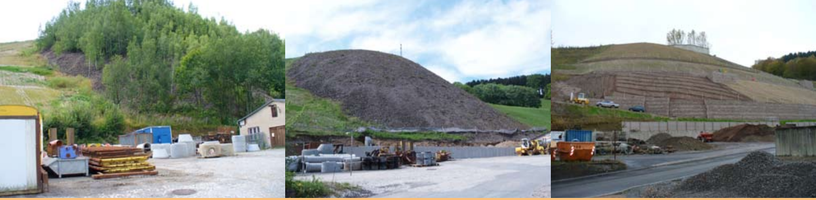
Sanierung der Halde 278, Schwarzenberg
