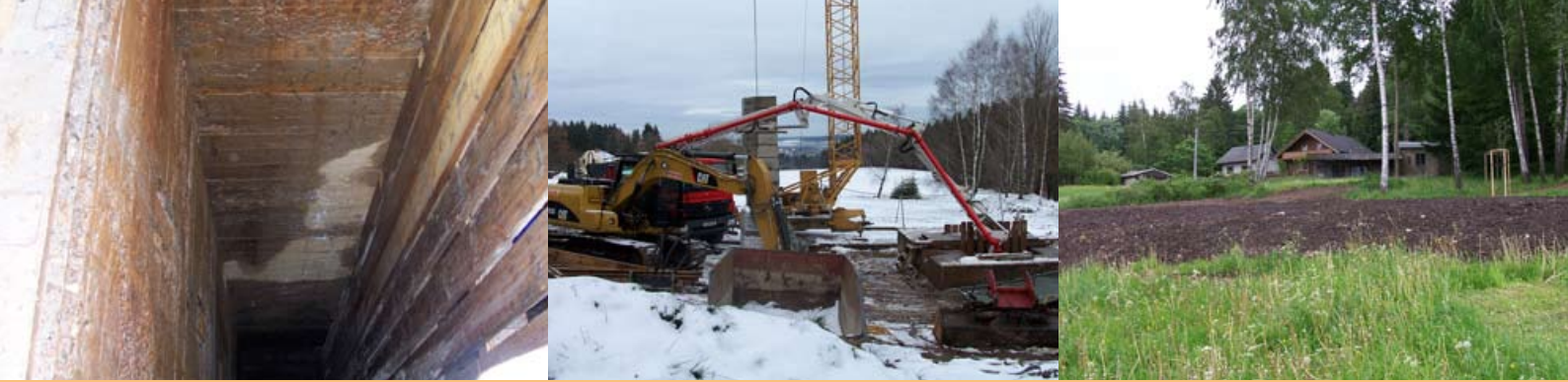
Verwahrung des Schachtes 381, Auerbach
