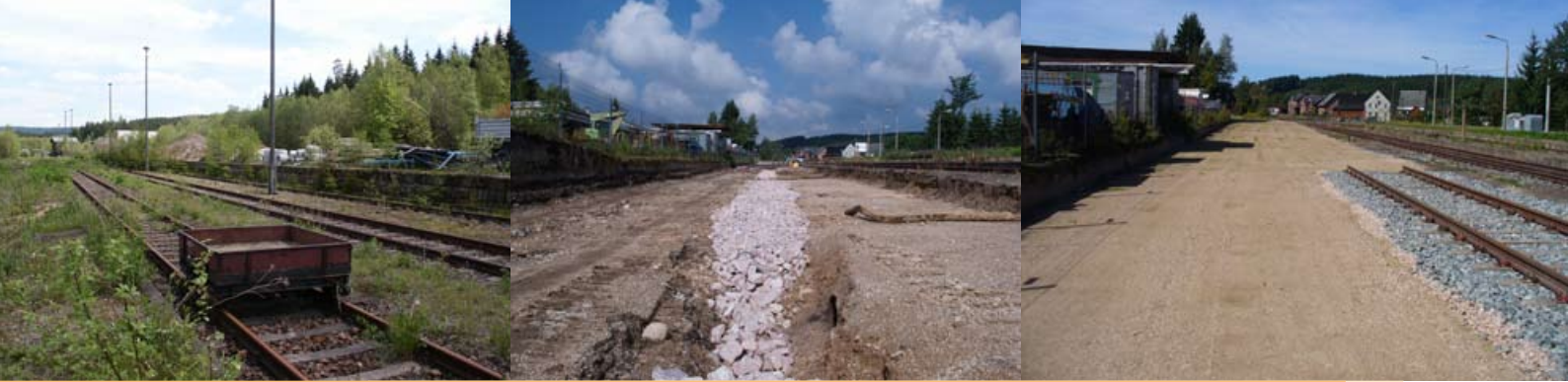
Sanierung der Erzverladung im Bahnhof Tannenbergsthal
