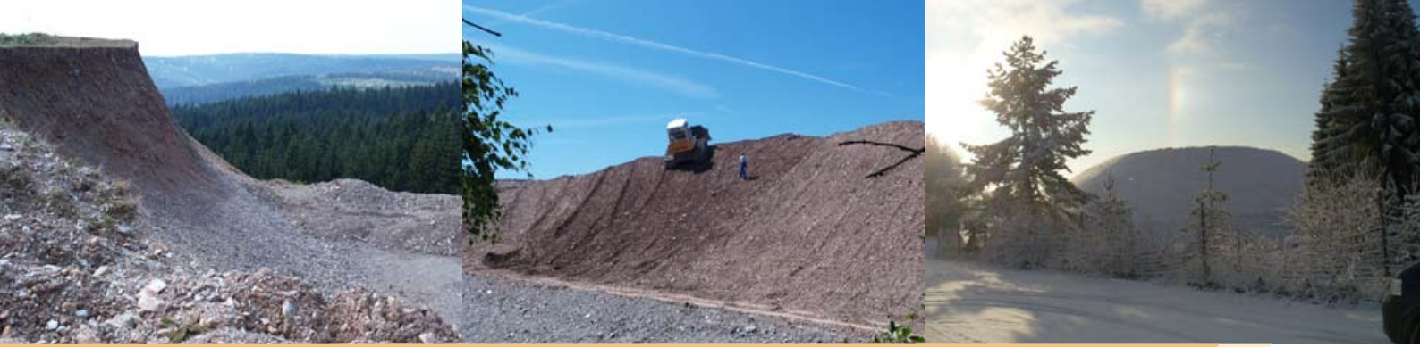
Sanierung der Halde 241, Tannenbergsthal
