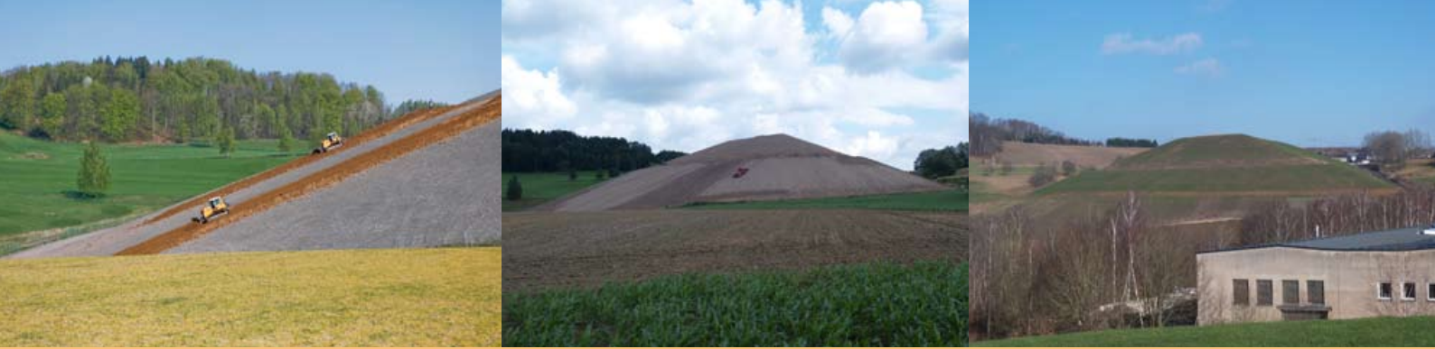
Sanierung der Halde 296, Aue
