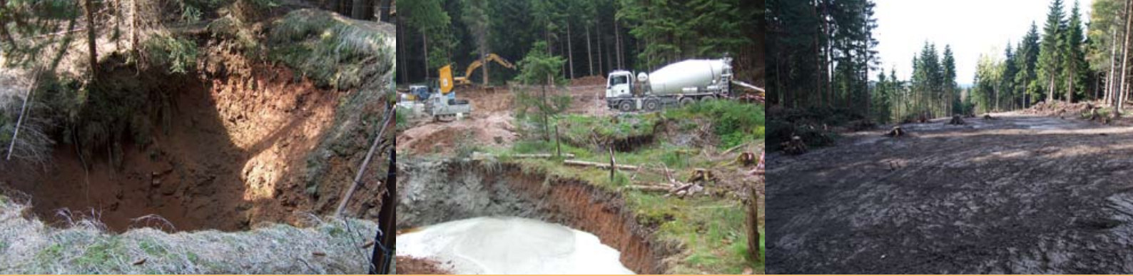
Verworksarbeiten im Verwasrbereich 1, Tannenbergsthal
