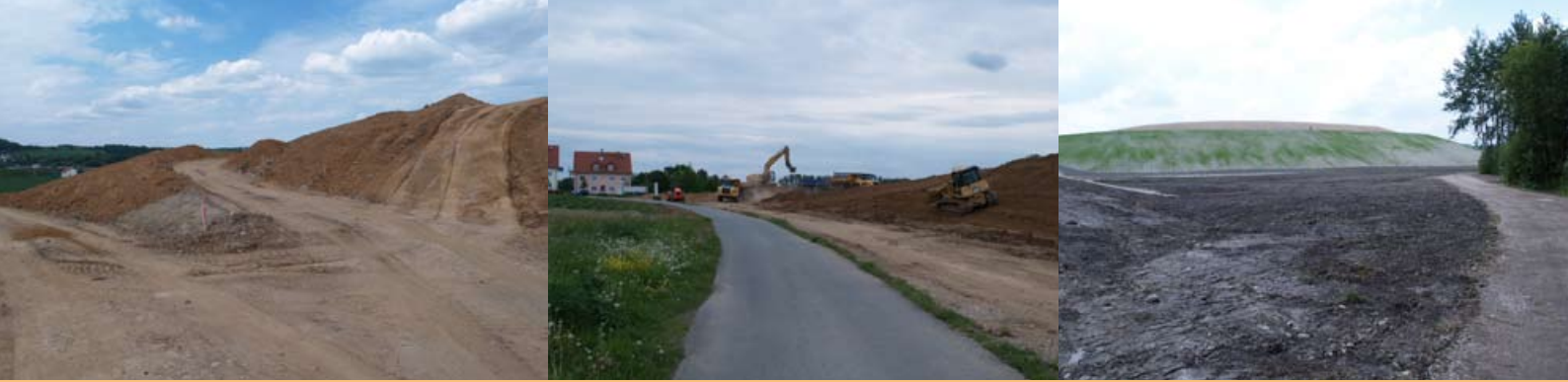
Sanierung der Halde Crossen, Zwickau
