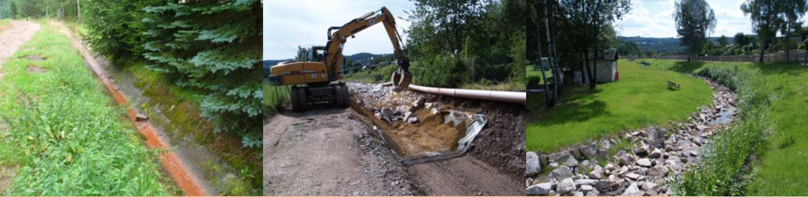
Sanierung des Silberbaches, Bad Schlema
