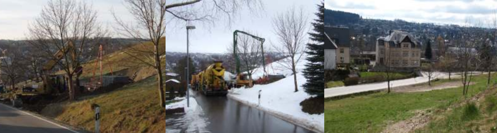
Verwahrung des Überhauns 27 (St. Georg-Walpurgis-Flachen), Schneeberg
