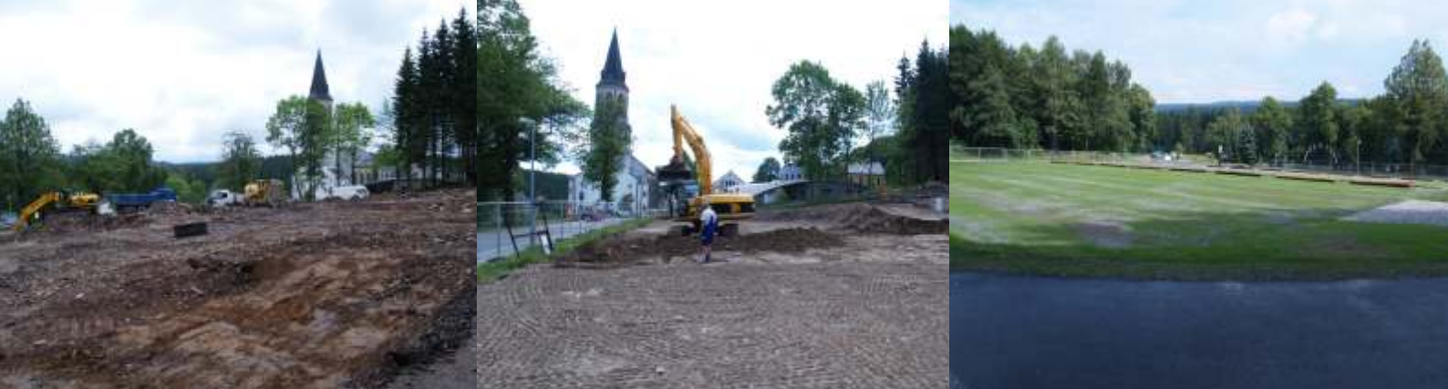
Sanierung des Flurstückes 2/68, Johannegeorgenstadt
