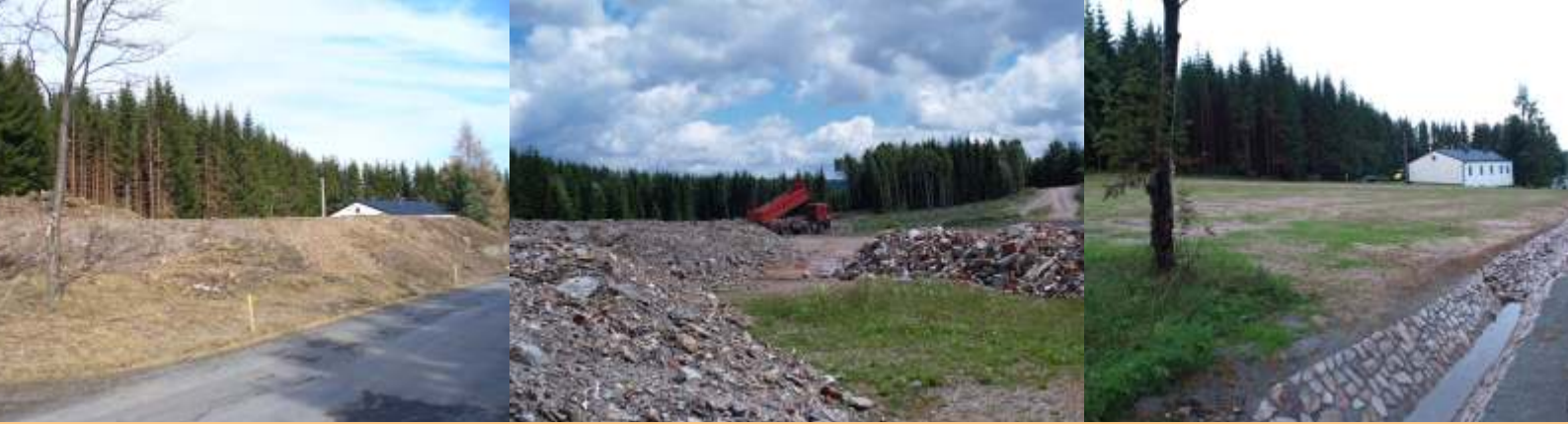
Sanierung der Halde 39, Johanngeorgenstadt
