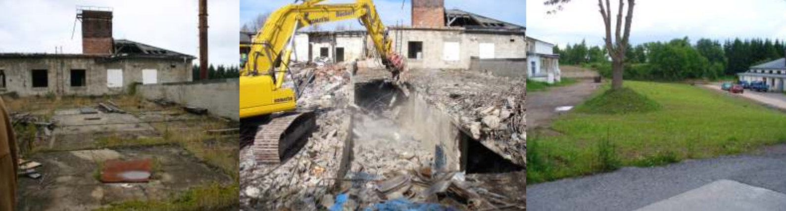
Sanierung der Betriebsfläche der Schächte 52/227, Johanngeorgenstadt
