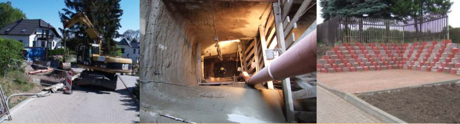
Verwahrung des Überhauns 28 (St. Georg-Walpurgis-Flachen), Schneeberg
