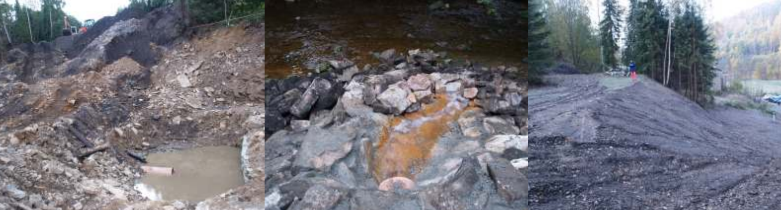
Sicherung und Verwahrung im Bereich des Abbaus 365, Breitenbrunn
