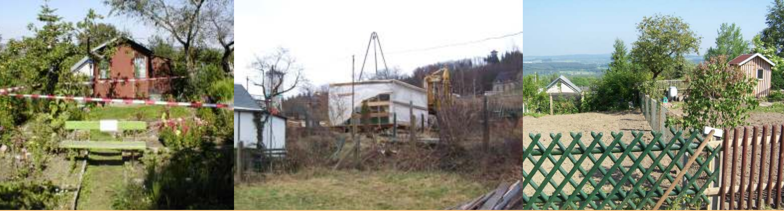
Verwahrung des Tagebruchs auf dem Flurstück 264/1, Scheibenberg
