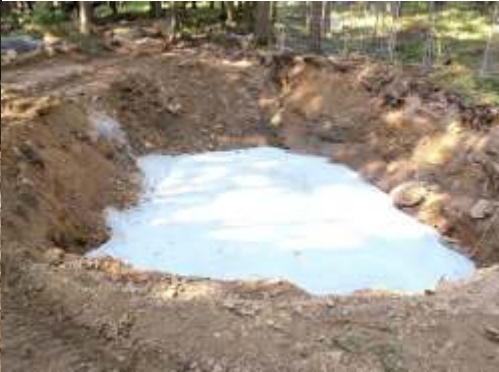
Schurf 43, Sehmatal: Fertige Betonplombe
