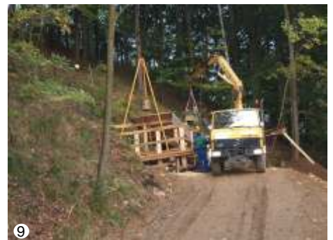
Fotos: 5,6,7 Mannschaftsstellen Zobes: während und nach Abschluss der Verwahrung 8,9,10 Überhauen Hakenkrümme, Aue: Tagesbruch vor und während der Verwahrung
