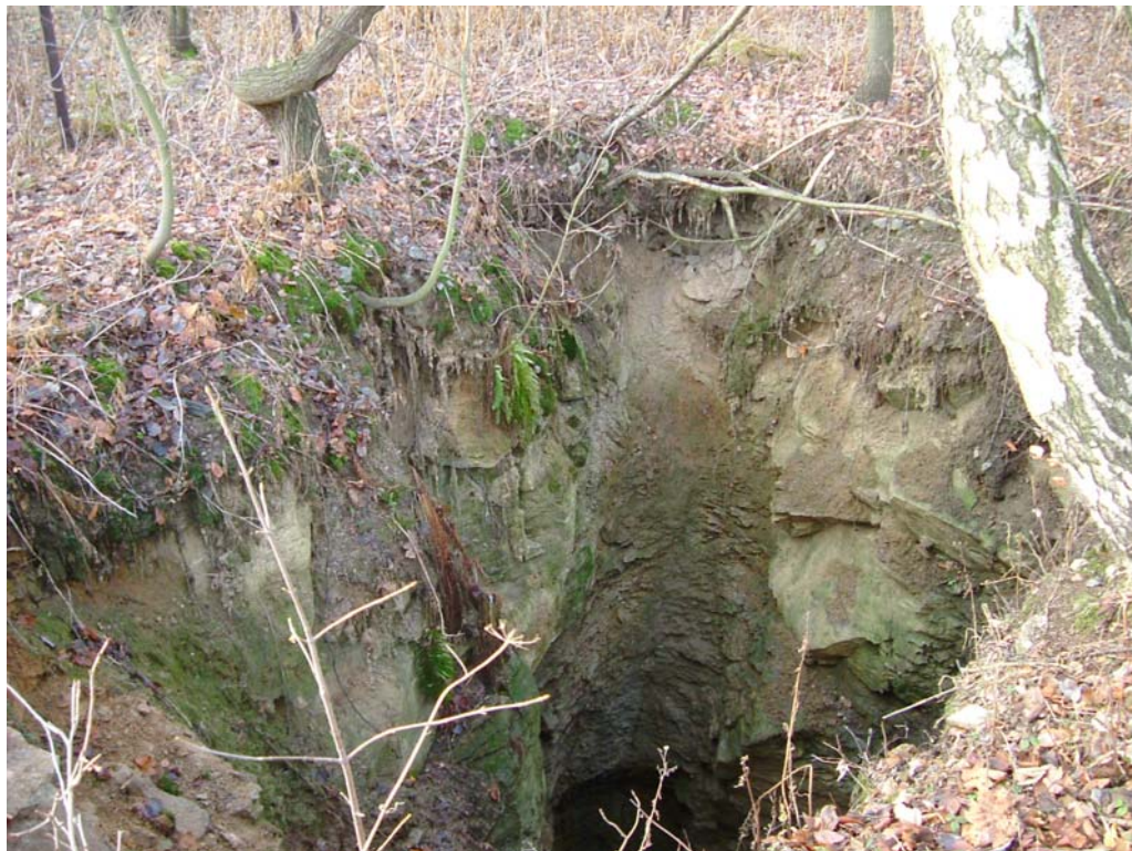
Tagesbruch auf Schurf 502 A (Aufnahme vom Dezember 2003)
