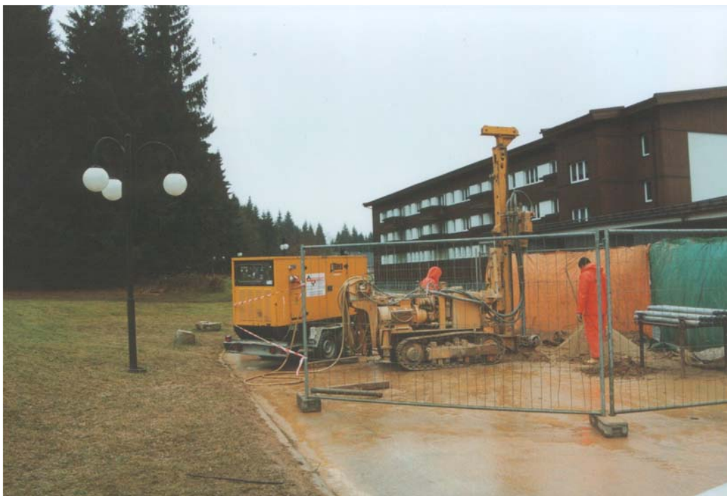
Bohrung auf Gang 288, November 2003
