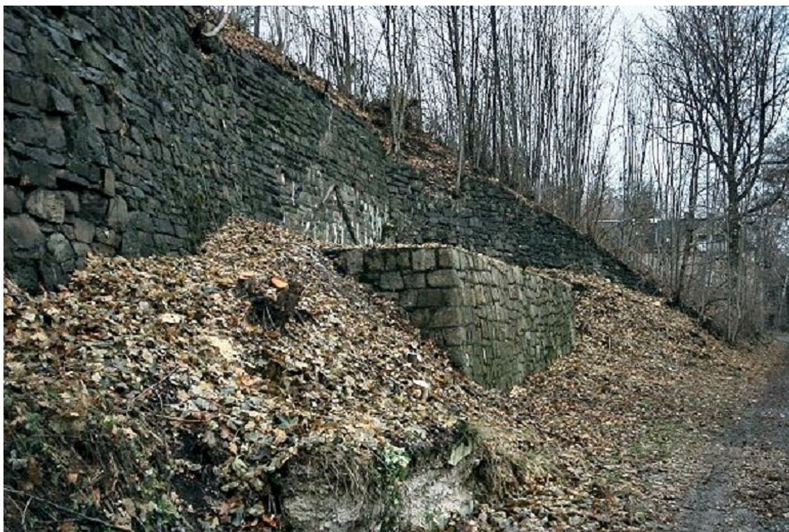
Erzverladestelle 2 nach Abschluß der Rodungsarbeiten, Nov. 2003
