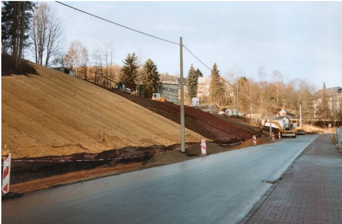
Erzbunker am Stolln 230 im November 2003
