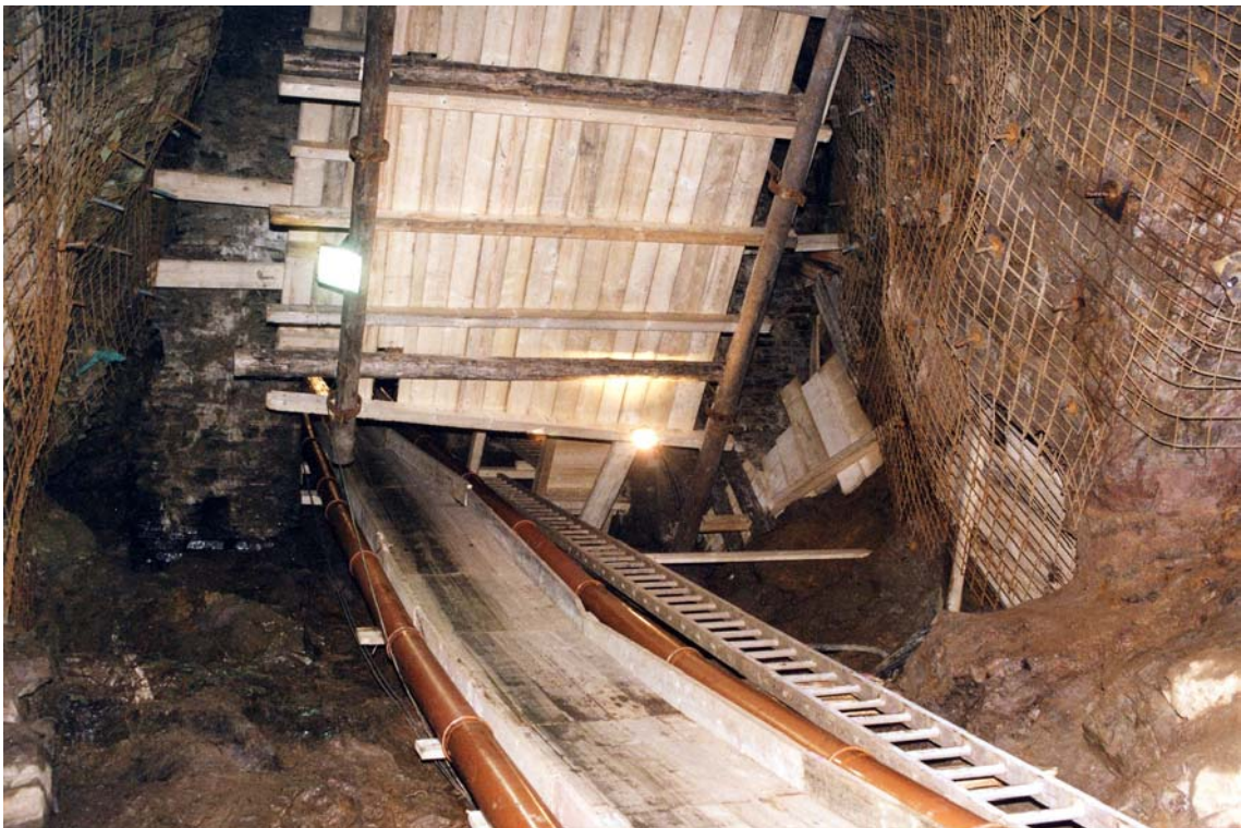
Schacht 43, Blick von der Sohle bei ca. 80 m nach oben in den Bereich der Profil- erweiterung
