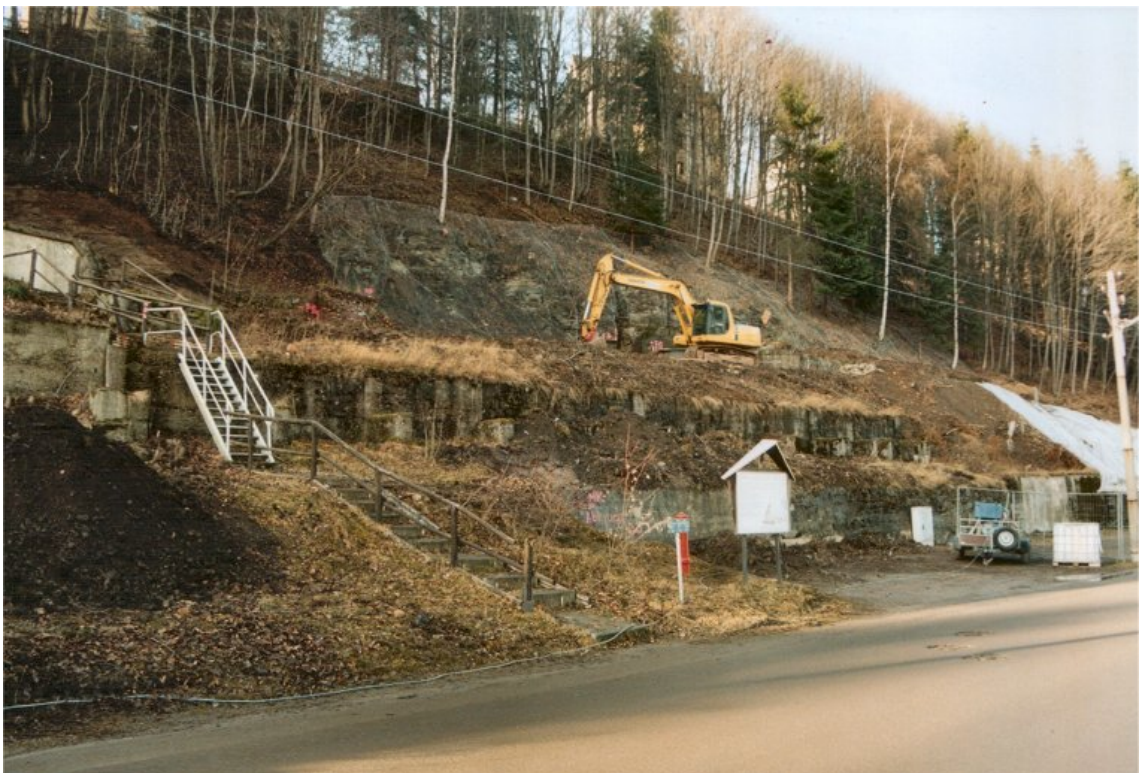
Sanierungsarbeiten an P 3.2 im November 2003
